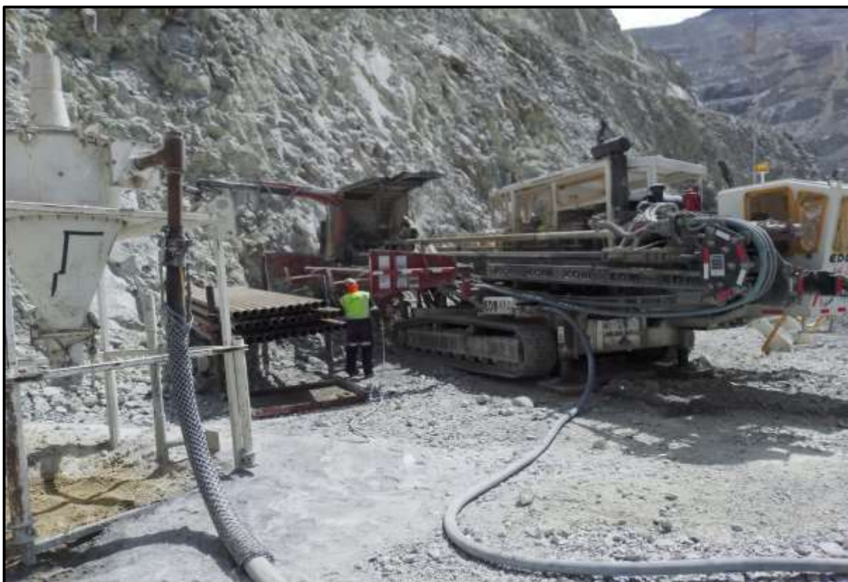
Figura 6 — Plataforma y perforación rotopercutiva
