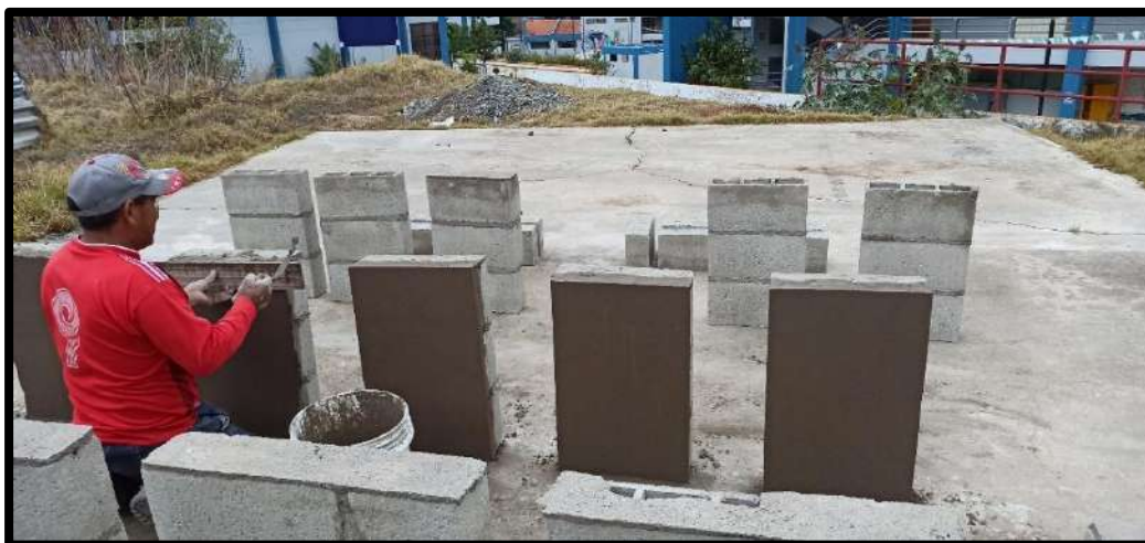
Figura 7 — Tarrajeo de cinco pilas de bloques de concreto
