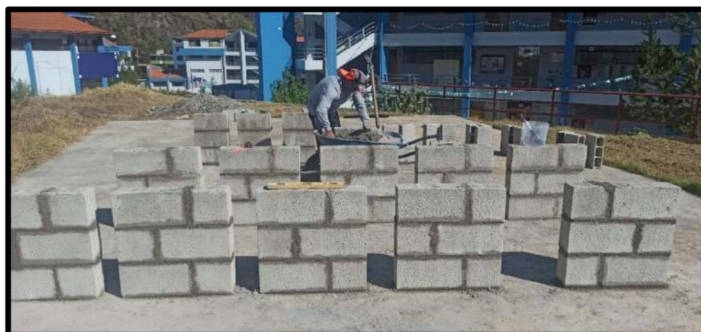
Figura 13 — Control de calidad y precisión en la construcción de muretes
