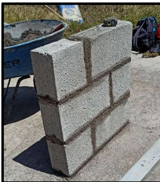
Figura 12 — Construcción de muretes de bloques de concreto
