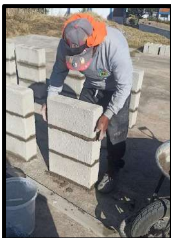
Figura 6 — Control de uniformidad en pilas de concreto
