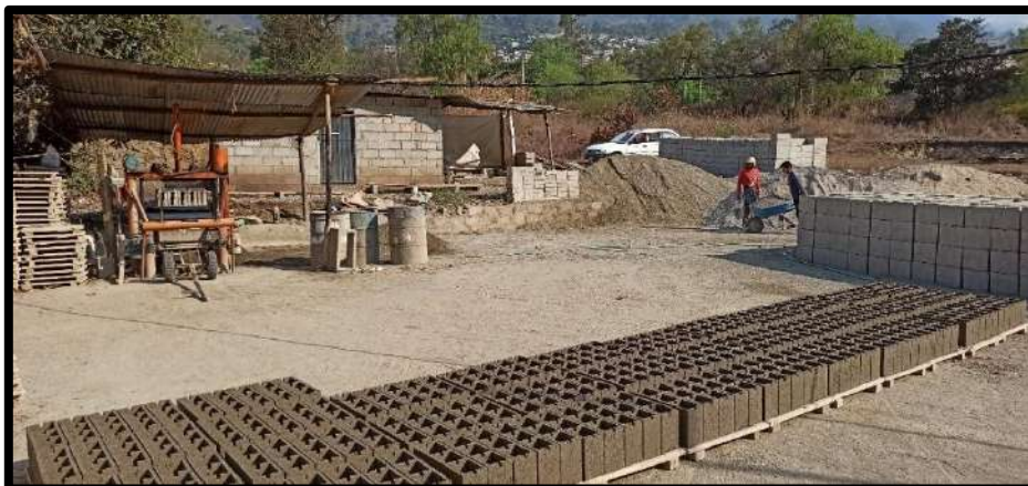
Figura 45 — Adquisición de bloques de concreto de planta
