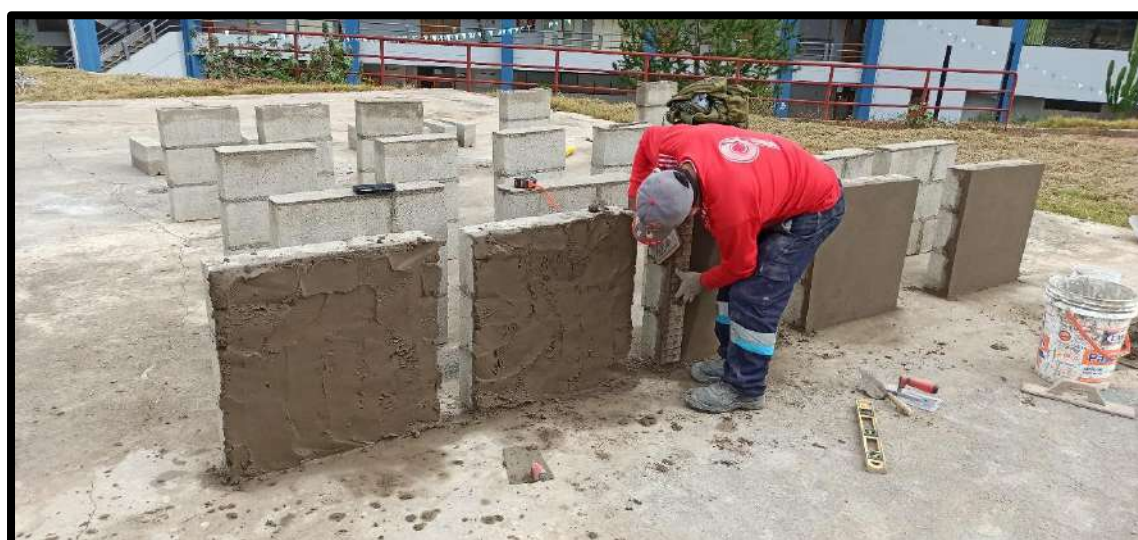
Figura 14 — Tarrajeo en muretes de bloques de concreto
