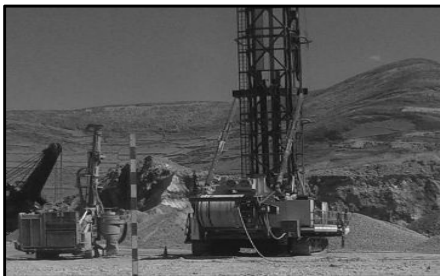
Figura N° 13: Equipos de perforación Mina Las Bambas.
