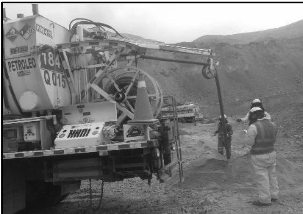
FOTO N° 13: Carguo de taladros con mezcla explosiva gasificada.
