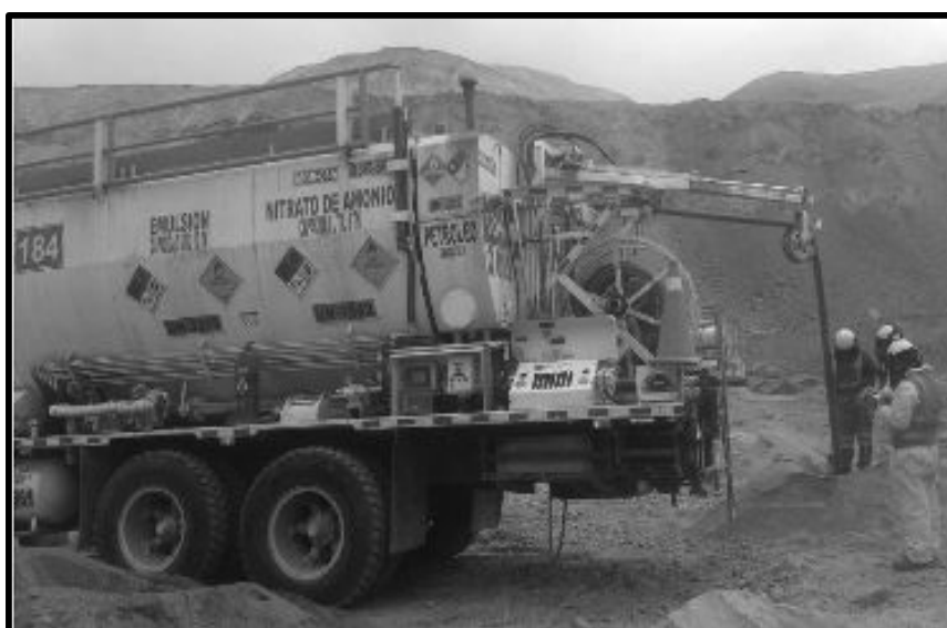
Figura N° 15: Camión mezclador sistema vaciable en Las Bambas.
