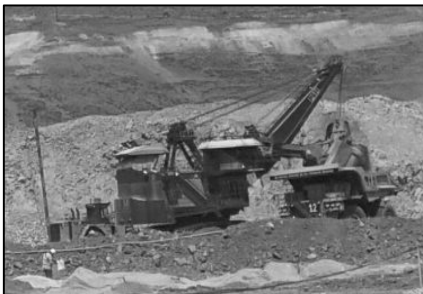
Figura N° 16: Carguío de mineral Las Bambas.
