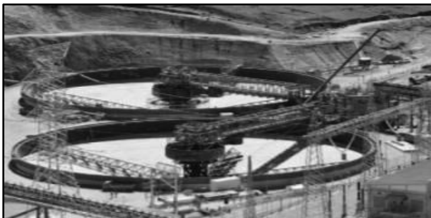
Figura N° 12: Espesadores Delkor Hi-rate Las Bambas.
