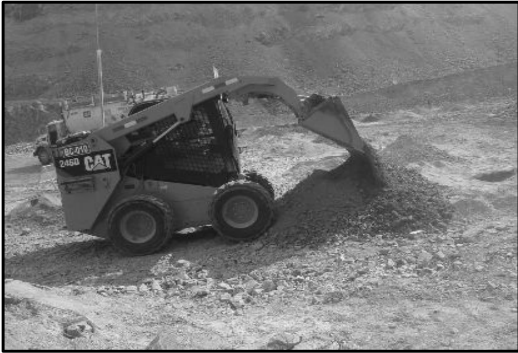
FOTO N° 14: Tapado de taladros con material inerte (gravilla).
