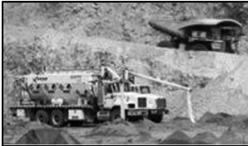
Figura N° 14: Camión mezclador sistema vaciable en Las Bambas.
