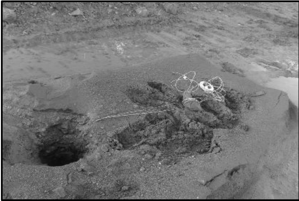
FOTO N° 08: Primado de taladro con accesorios de voladura.
