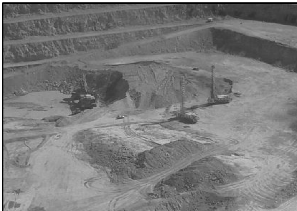
FOTO N° 03: Zona Jahuapaylla del Tajo Ferrobamba Las Bambas.
