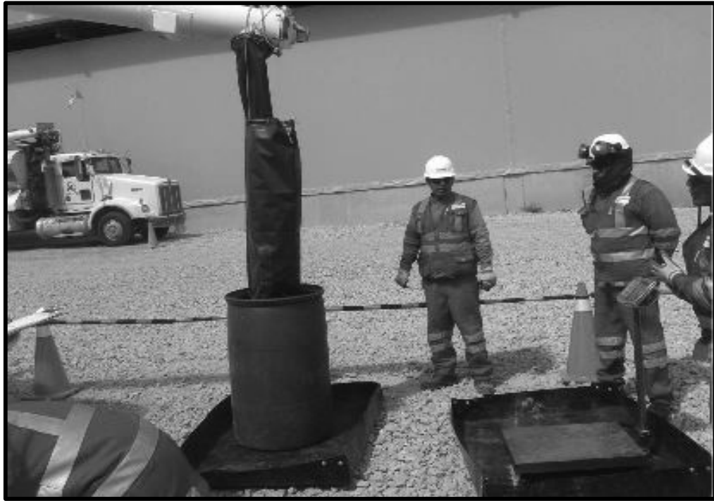
FOTO N° 06: Calibracion del camion fabrica con los agentes de voladura.
