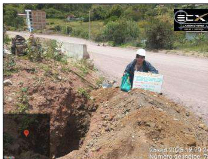
Imagen 03: CALICATA No C-3
