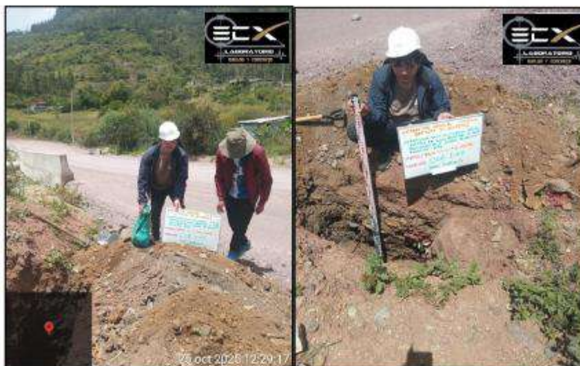
Imagen 04: CALICATA No C-4
