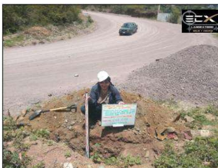
Imagen 06: CALICATA No C-6
