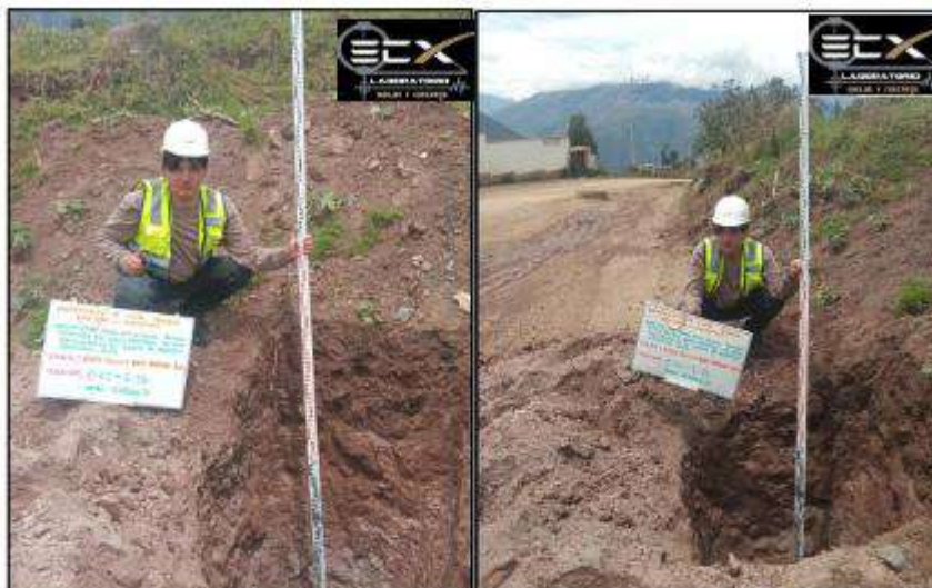
Imagen 01: CALICATA No C-1
