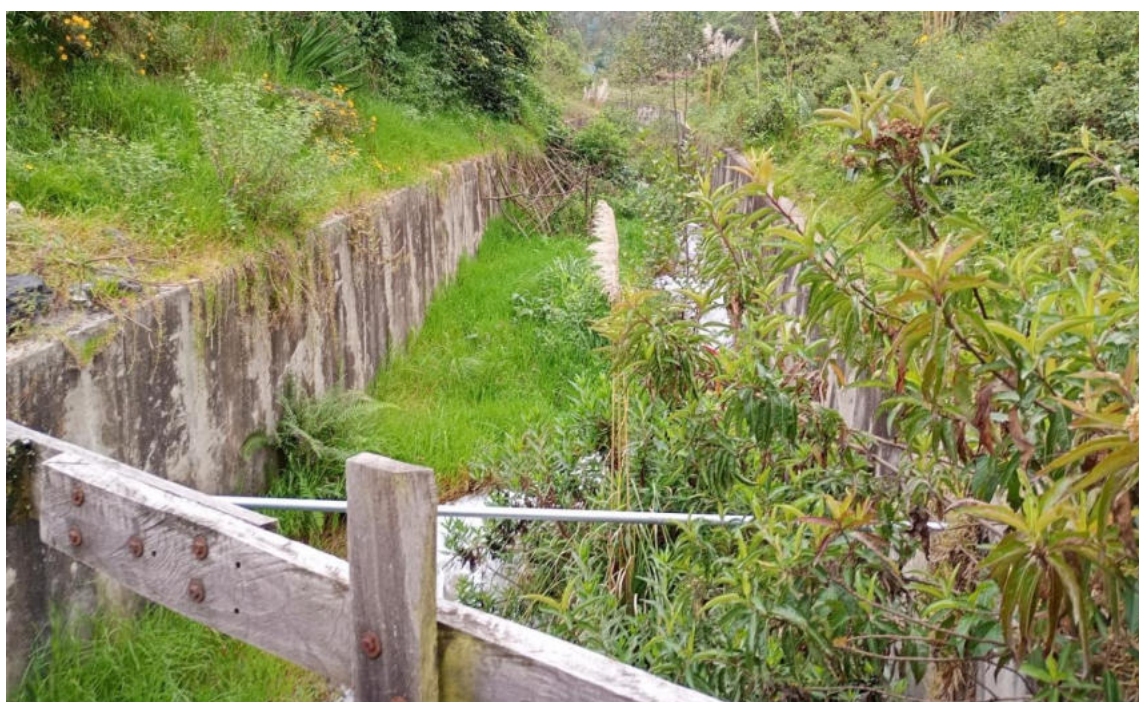
Figura 13 — Canal cubierto de vegetación
