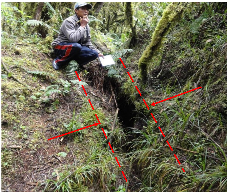
Figura 22 — Deslizamiento horizontal en cerro Chuyllurpata (2012)
