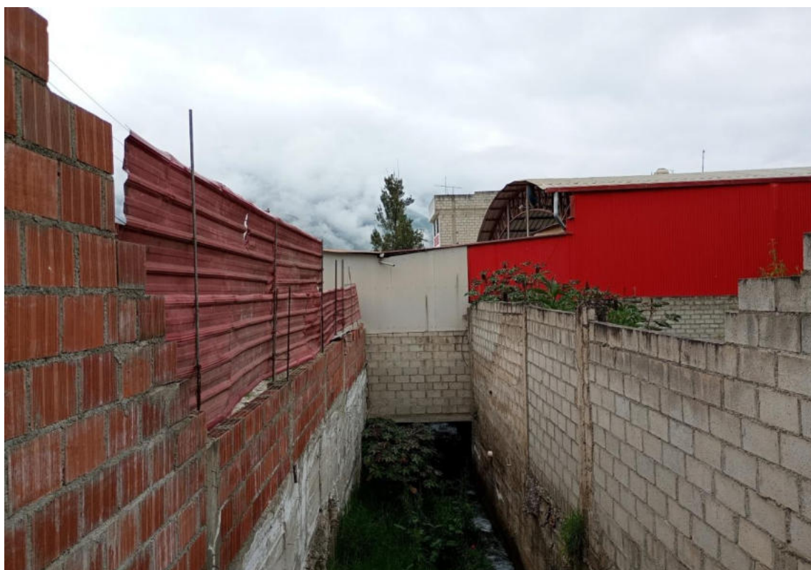
Figura 14 — Construcción de vivienda sobre el cauce de la quebrada.
