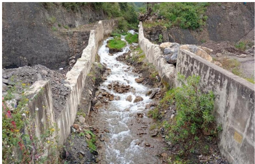
Figura 14 — Canalización de la quebrada Sahuanay, con estructuras
