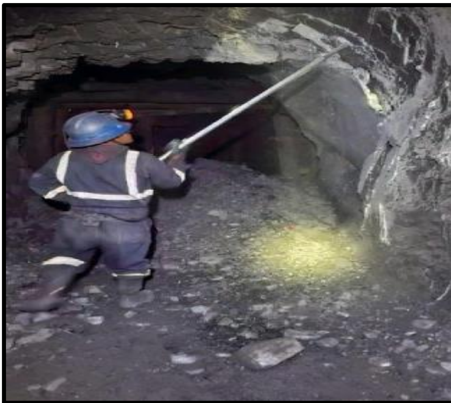
Figura 40 — Desatado para perforación GL 559 Nv 8
