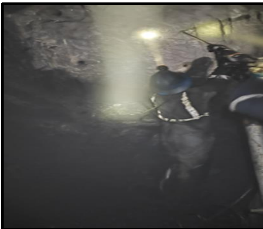
Figura 42 — Perforación de frente GL 599 Nv 8
