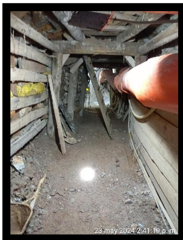
Figura 35 — Vista de una galería con su manga de ventilación.
