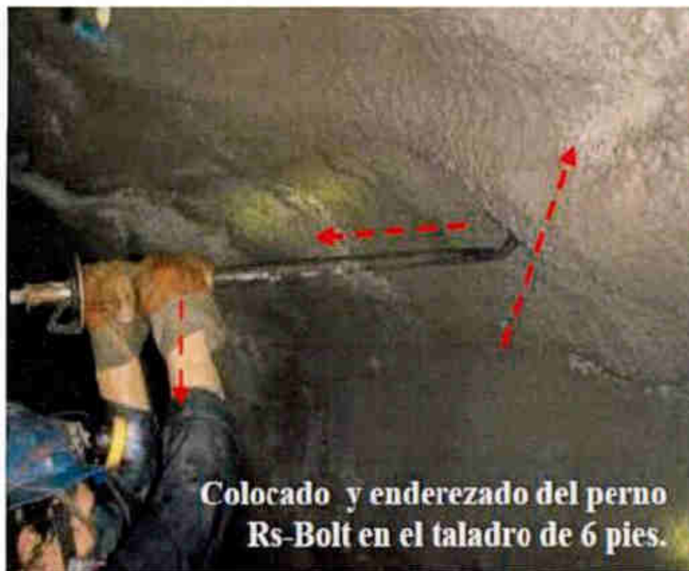
Fotografía 4. 3. Instalación del perno mediante el efecto palanca:
