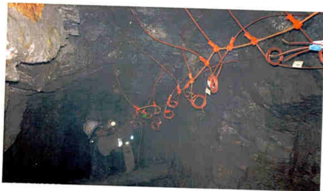
Fotografía muestra el amarre de los accesorios no eléctricos con faneles periodo corto (mininel).
