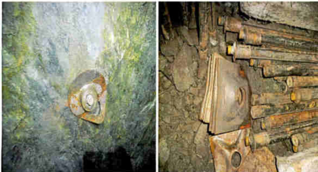
Fotografía muestra soporte" Rs bolt "instalado en la caja techo del tajo 5960.
