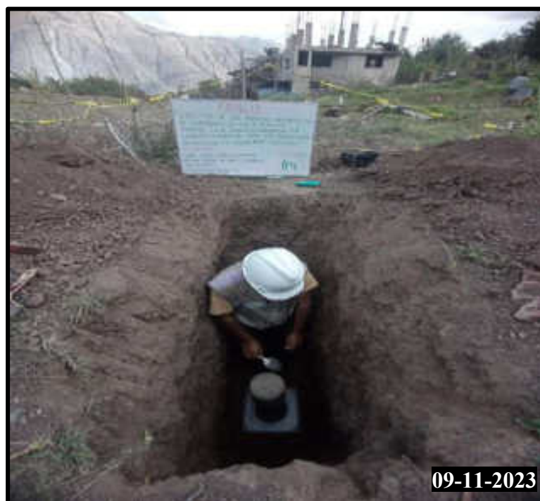
Figura 180 — Realización del ensayo de densidad in-situ de la calicata 04
