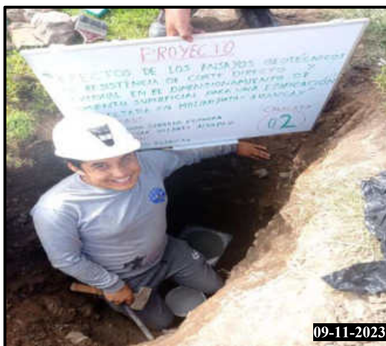
Figura 178 — Realización del ensayo de densidad in-situ de la calicata 02
