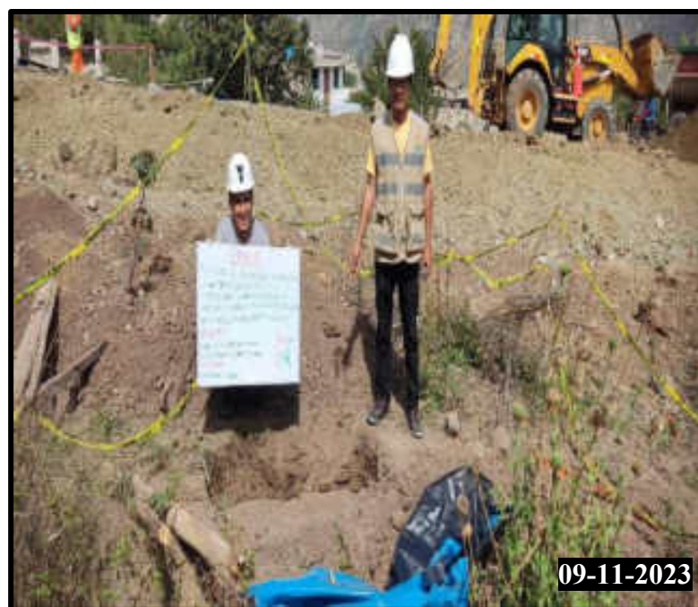
Figura 174 — Excavación y muestreo de la calicata 04
