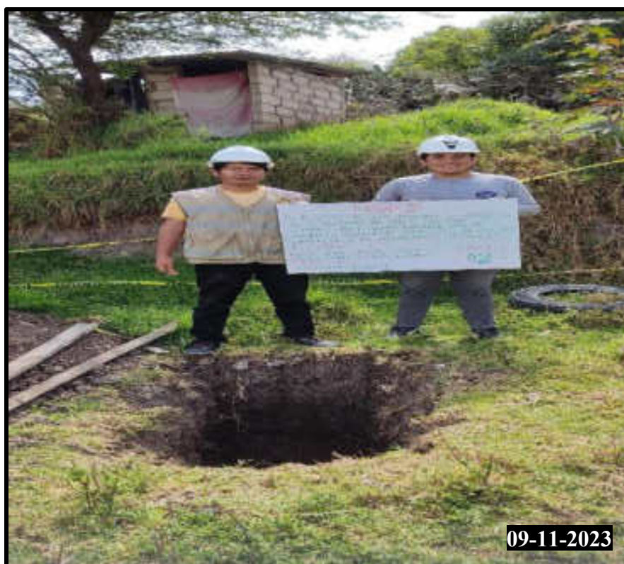
Figura 170 — Excavación y muestreo de la calicata 02
