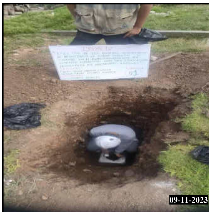
Figura 177 — Densidad de campo in-situ en la calicata 01
