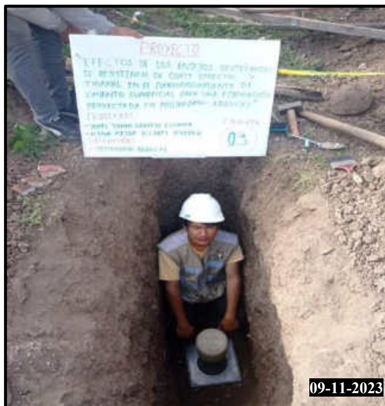
Figura 179 — Densidad de campo in-situ en la calicata 03
