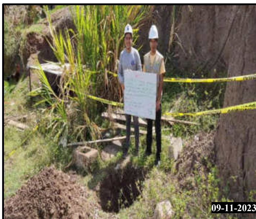
Figura 172 — Excavación y muestreo de la calicata 03
