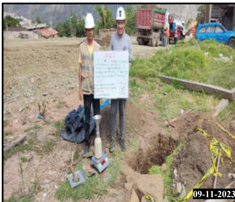
Figura 176 — Realización del ensayo de densidad in-situ de la calicata 01
