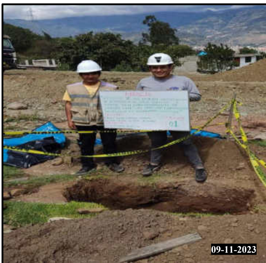
Figura 168 — Excavación y muestreo de la calicata 01
