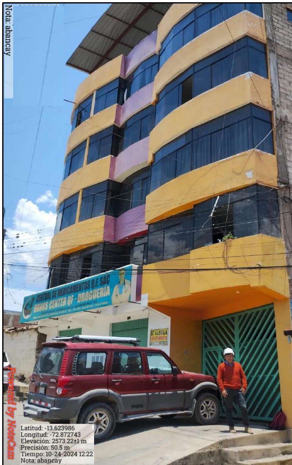
Figura 80 — Imagen de la estructura desde su fachada frontal
