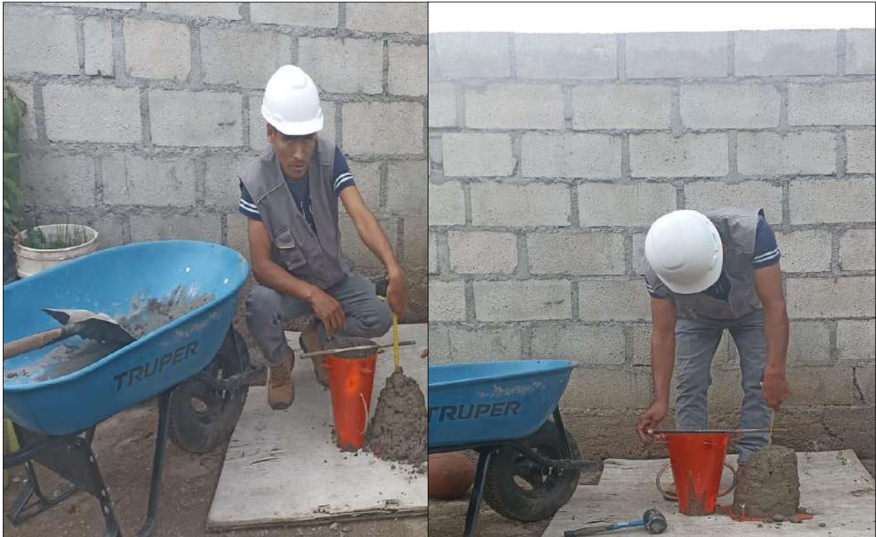
Figura 63 — Determinación del asentamiento del concreto fresco
