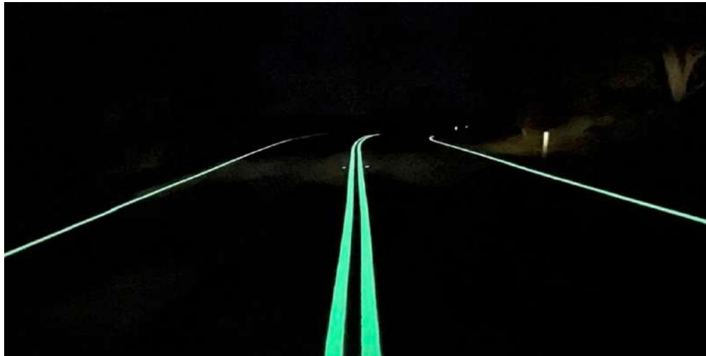
Figura 2 — Señalización horizontal de tránsito con materiales luminiscentes
