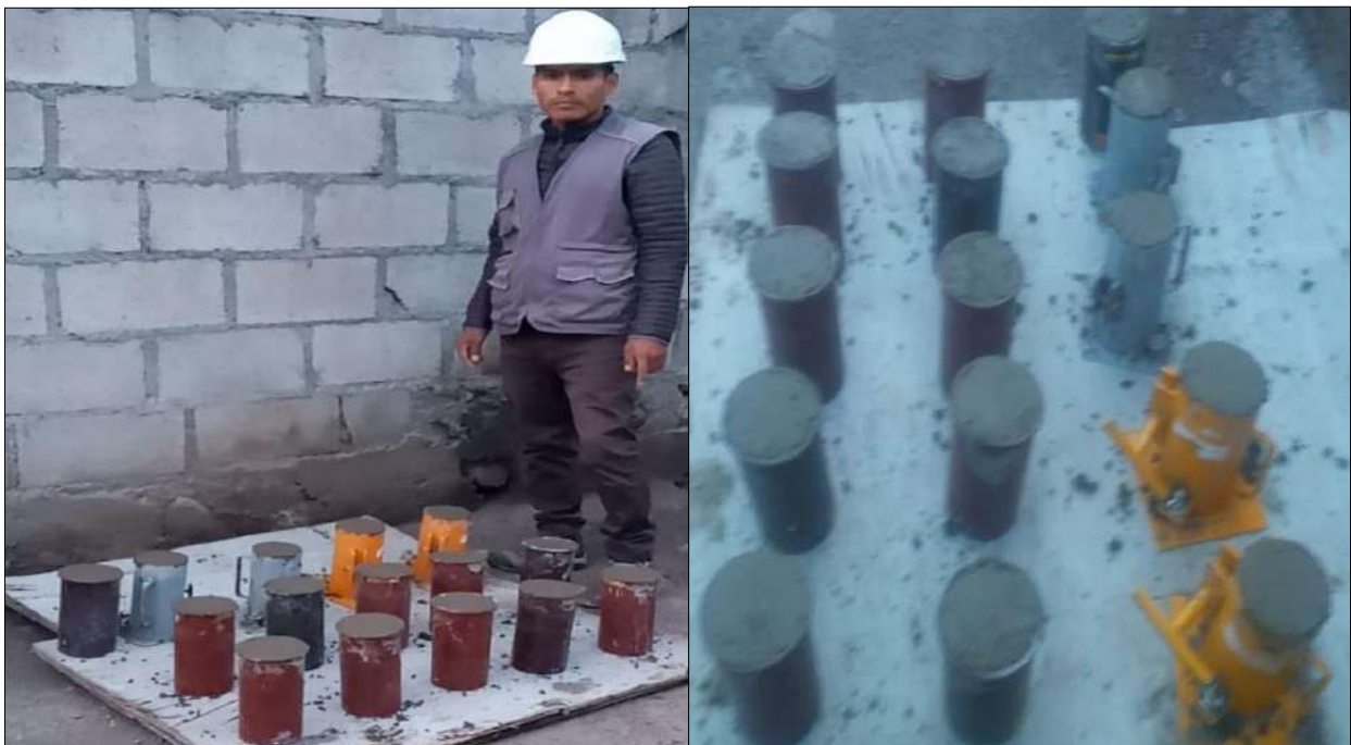
Figura 64 — Elaboración de especímenes de concreto
