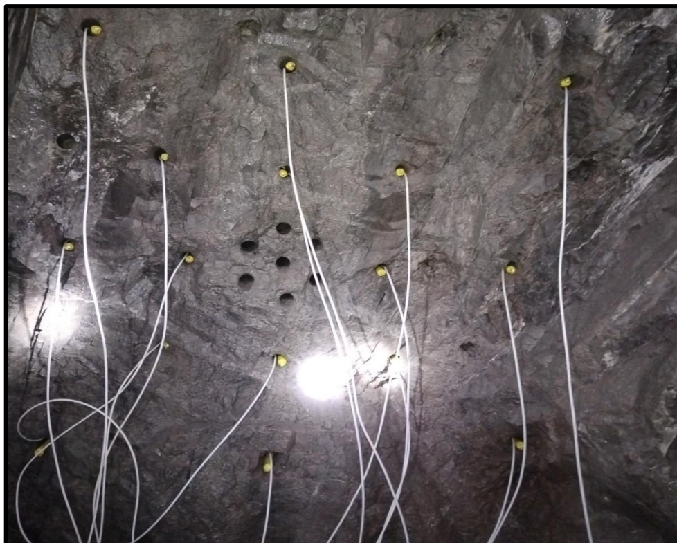
Figura 20 — Carguío de taladros en frente de perforación
