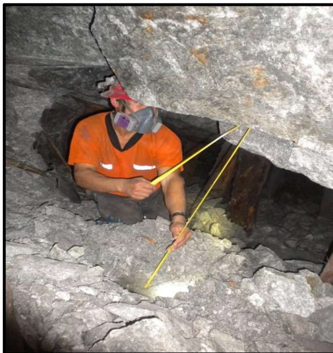
Figura 14 — Medición para colocados de sostenimiento con puntal
