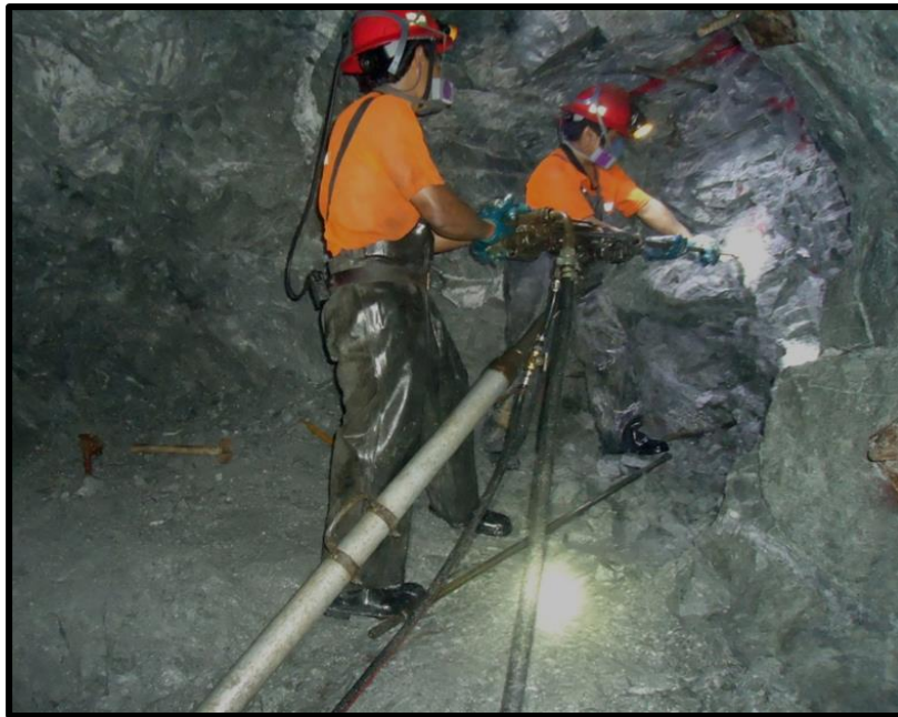
Figura 16 — Trabajos de perforación y voladura
