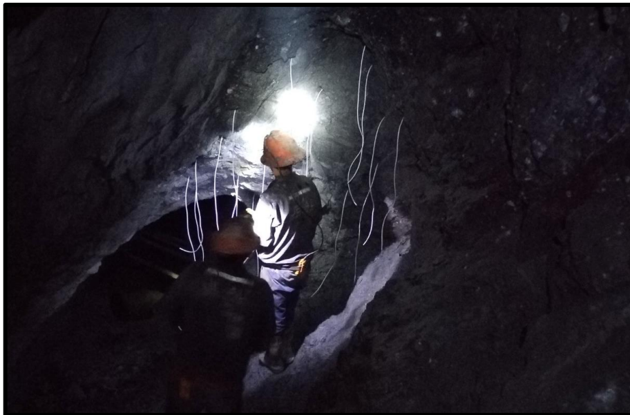
Figura 19 — Carguío de taladros para la voladura
