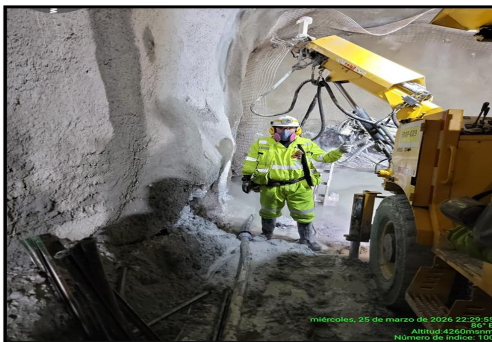
Figura 18 — Dimensiones de perno omega bolt a cada 1.5mx 1.5 m
