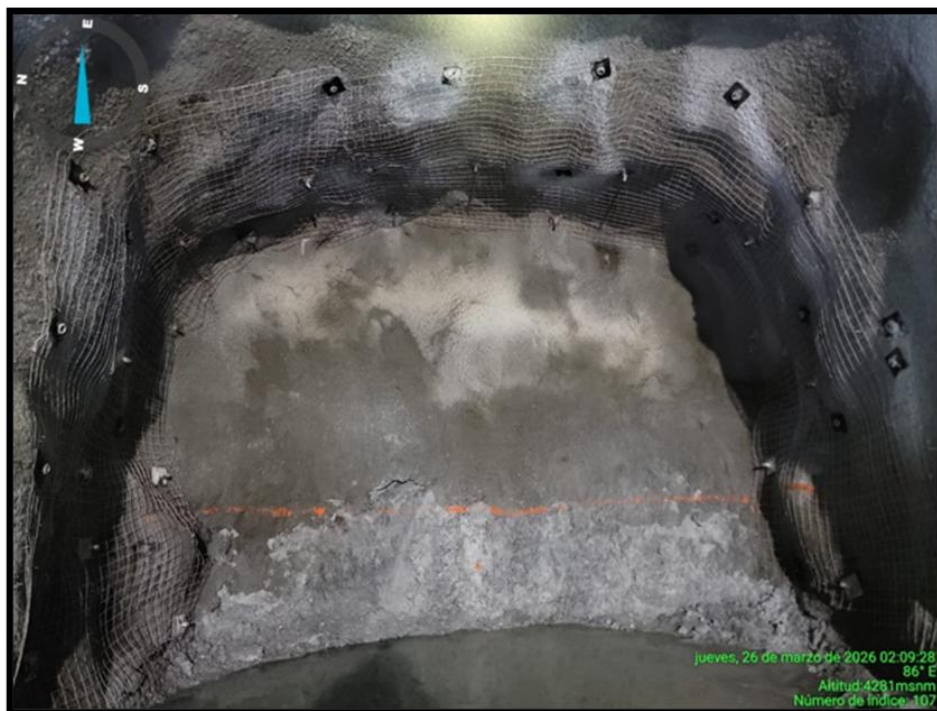
Figura 23 — Culminación de sostenimiento activo y pasivo en la RP (-) 7001
