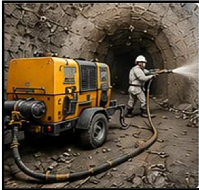
Figura 10 — Lanzado de capa preventiva frentes de avance
