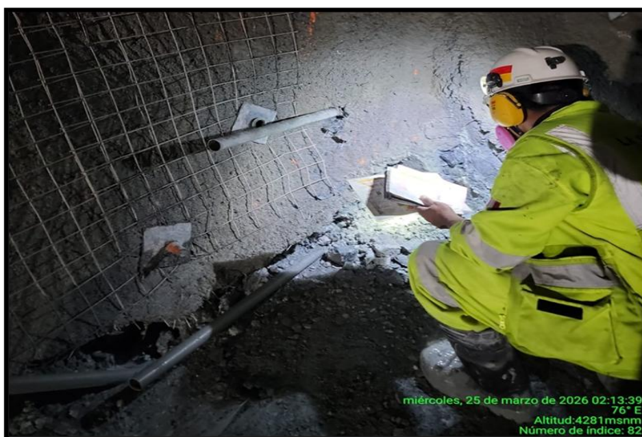
Figura 14 — Análisis de tipo de roca presente en frente de trabajo
