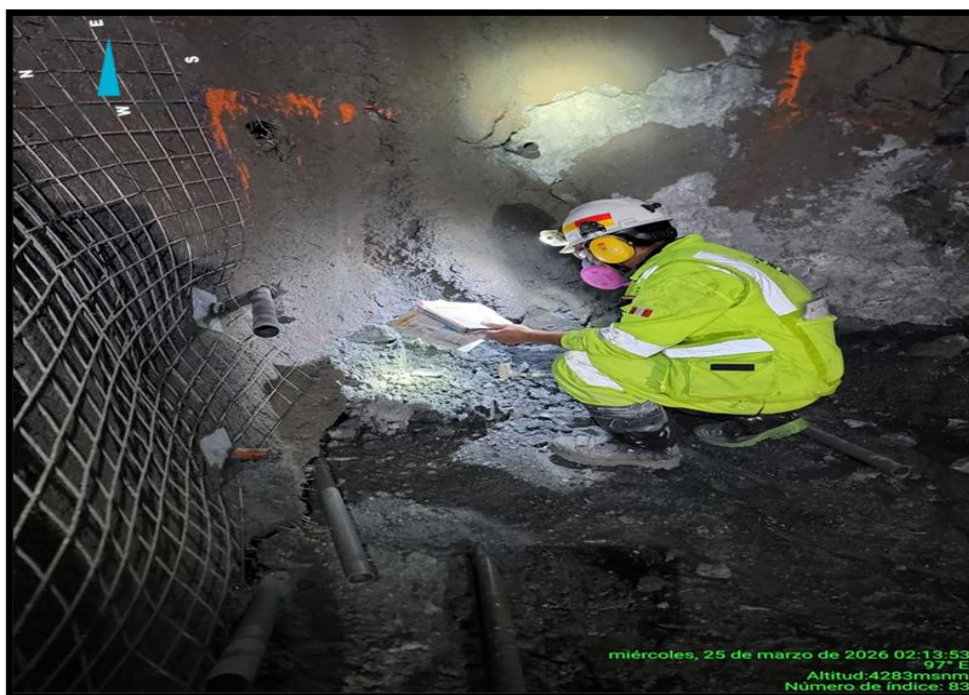
Figura 16 — Dimensiones de perno a perno aplicado en el área de trabajo
