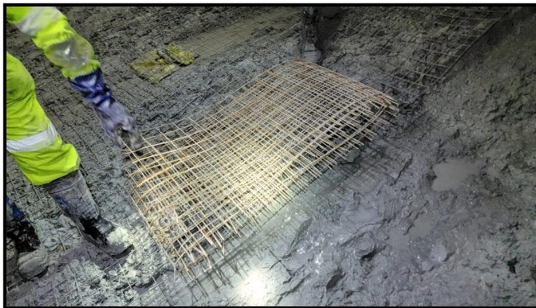
Figura 25 — Traslape de malla electrosoldada en el frente
