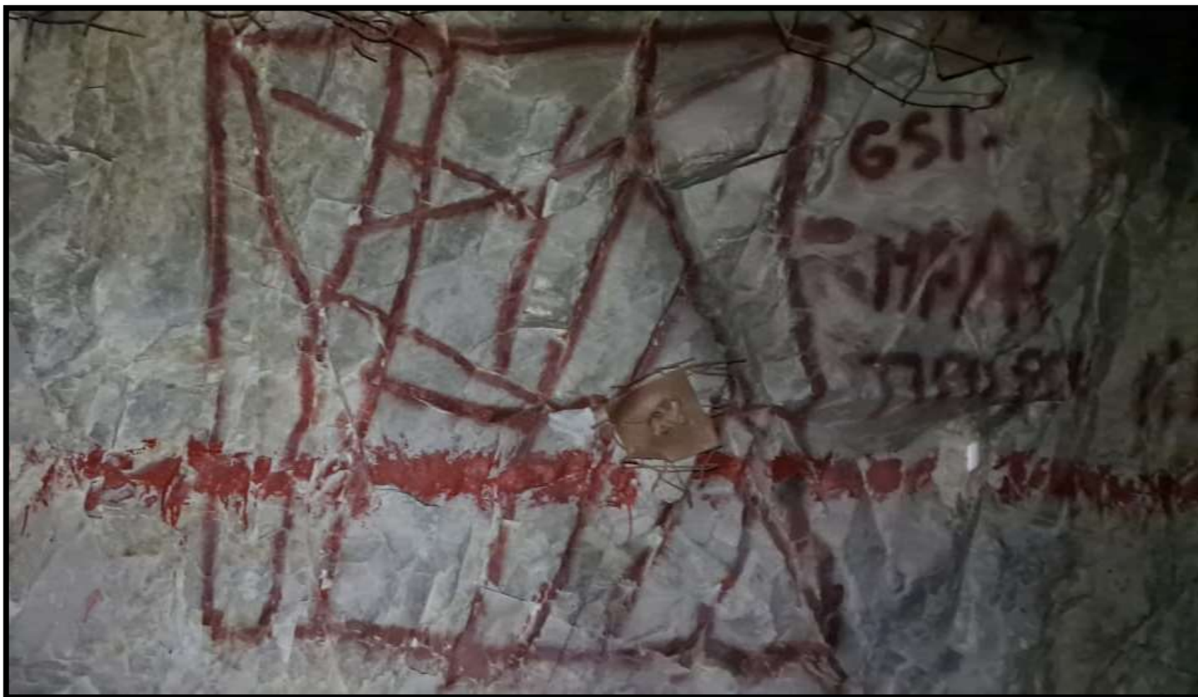
Figura 20 — Levantamiento geo mecánico en hastial derecho en interior mina
