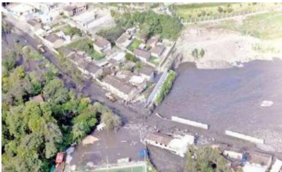
Figura 89 — Flujo de detritos ocurrido el 18 de marzo del 2012
