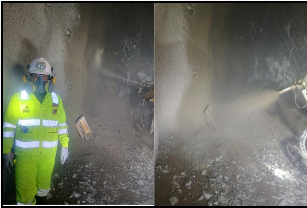
Figura 53 — Muestreo de resistencias iniciales
