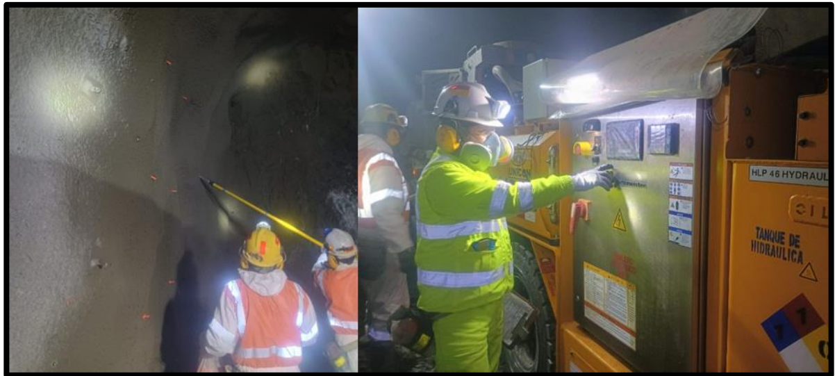
Figura 55 — Lanzado de shotcret
