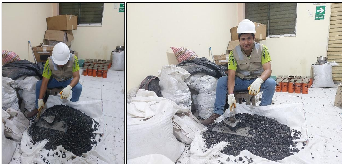
Figura 130 — Trituración y preparación del pavimento asfáltico reciclado
