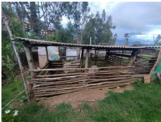
Fig. 14. Porqueriza amplia de troncos y con techo de calamina
