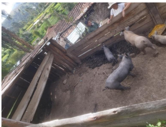
Fig. 15. Reproductoras hembras en una porqueriza de madera, troncos y calamina
