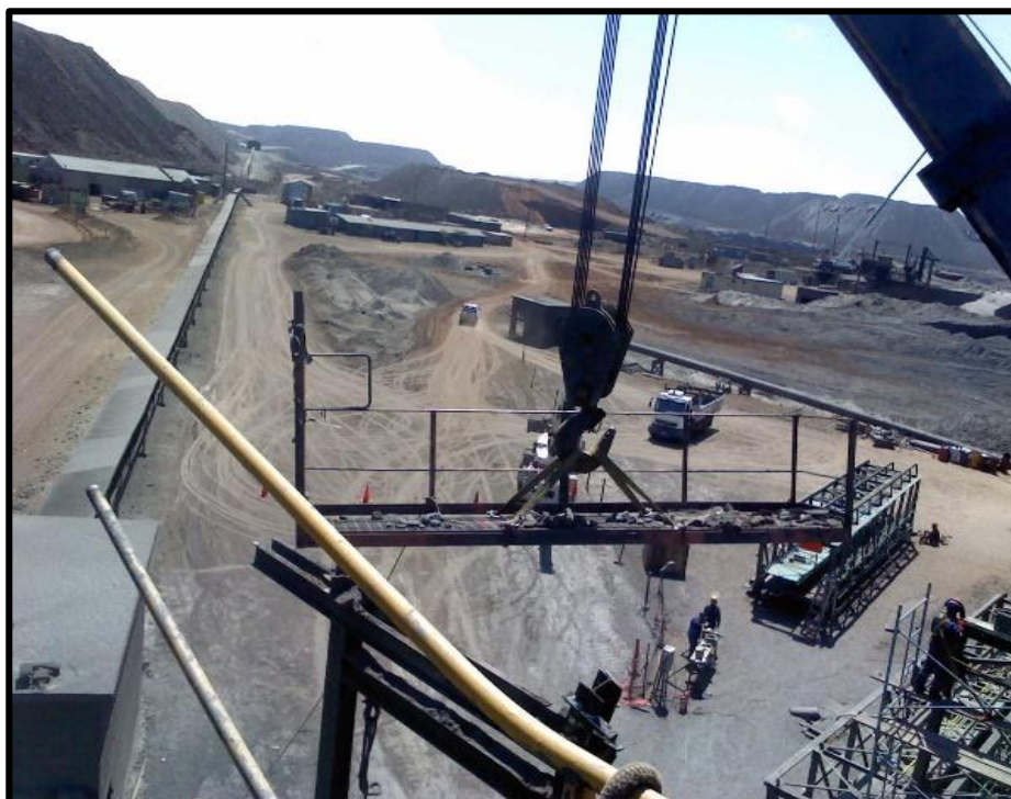
FOTO N° 4: trabajos de mantenimiento en la faja transportadora en mina.
