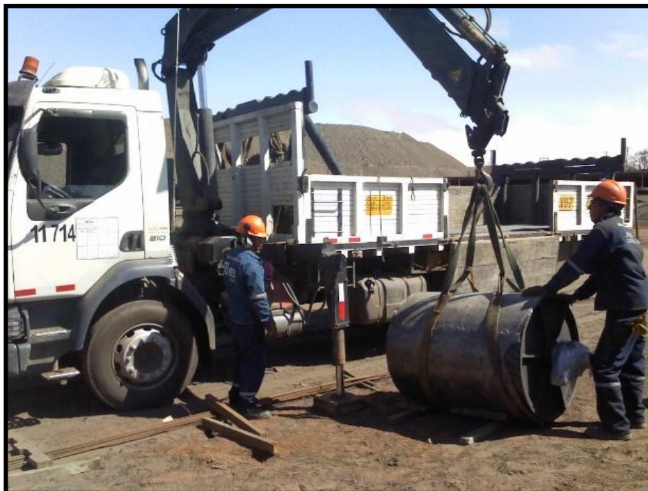
FOTO N° 1: realizando el transporte de la polea para la banda transportadora.
