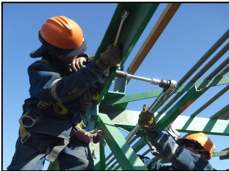
FOTO N° 5: Realizando el troque en los pernos de estructuras de la faja.
