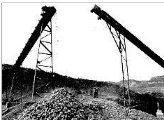
Figura II-15. Cintas transportadoras careciendo de plataforma y de pasarela.
