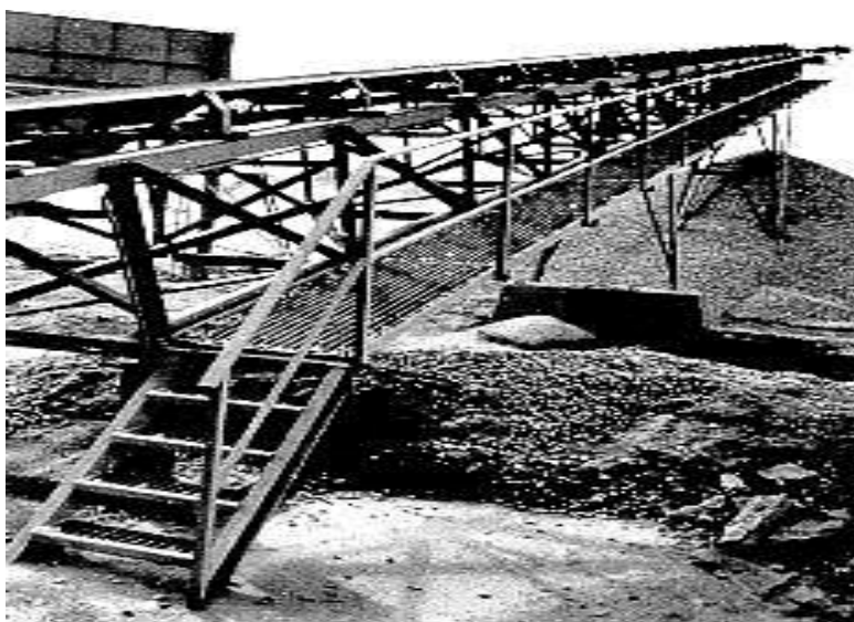
Figura II-17. Escalerilla de acceso y pasarela de mantenimiento e inspección.
