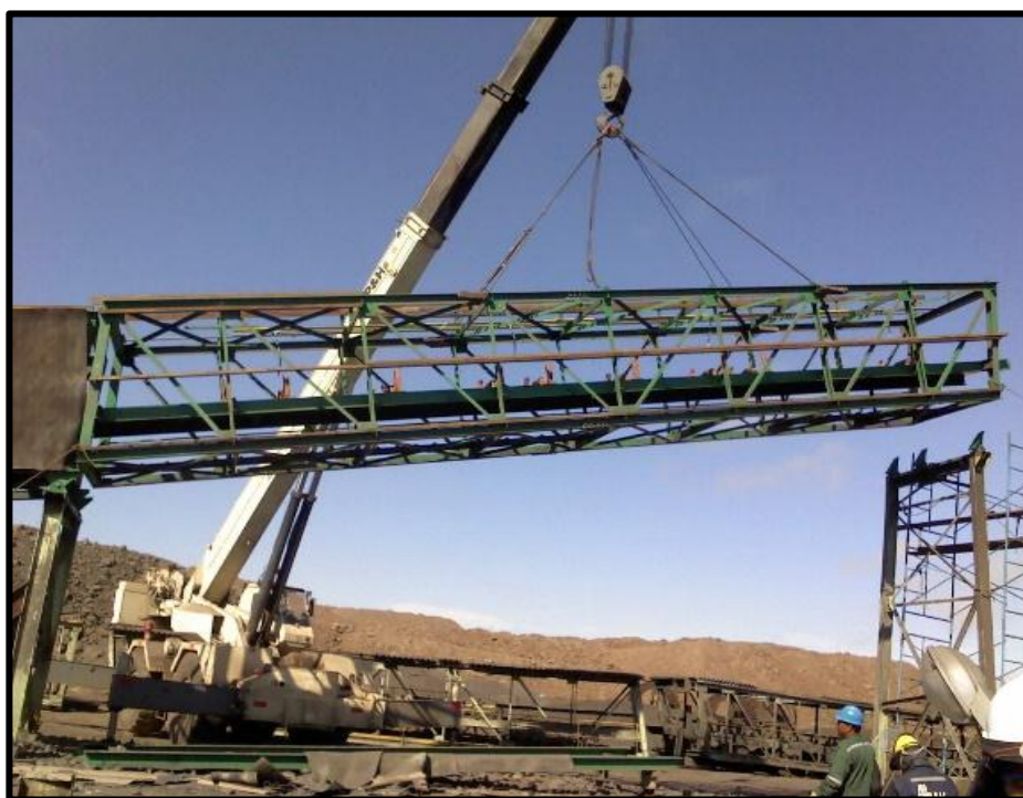
FOTO N° 2: montaje de la galería de estructura para la faja transportadora.
