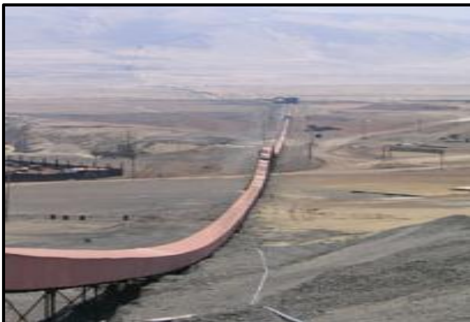
FOTO N° 3: línea de faja transportadora que va de mina a la planta.
