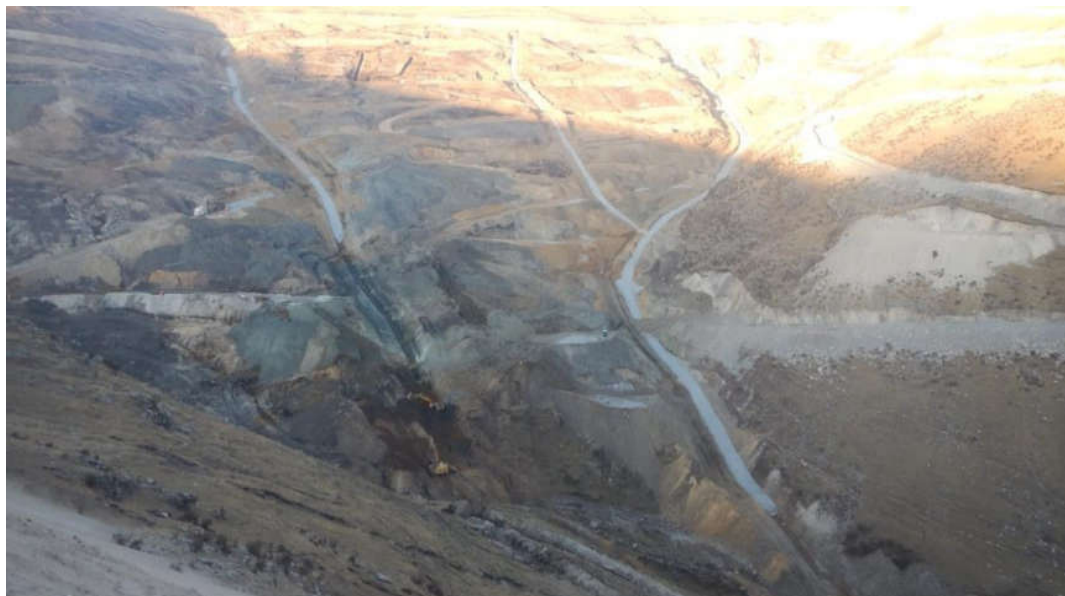
Imagen 9. Subdrenes auxiliares en Botadero Ferrobamba (Fuente: Autor de tesis).
