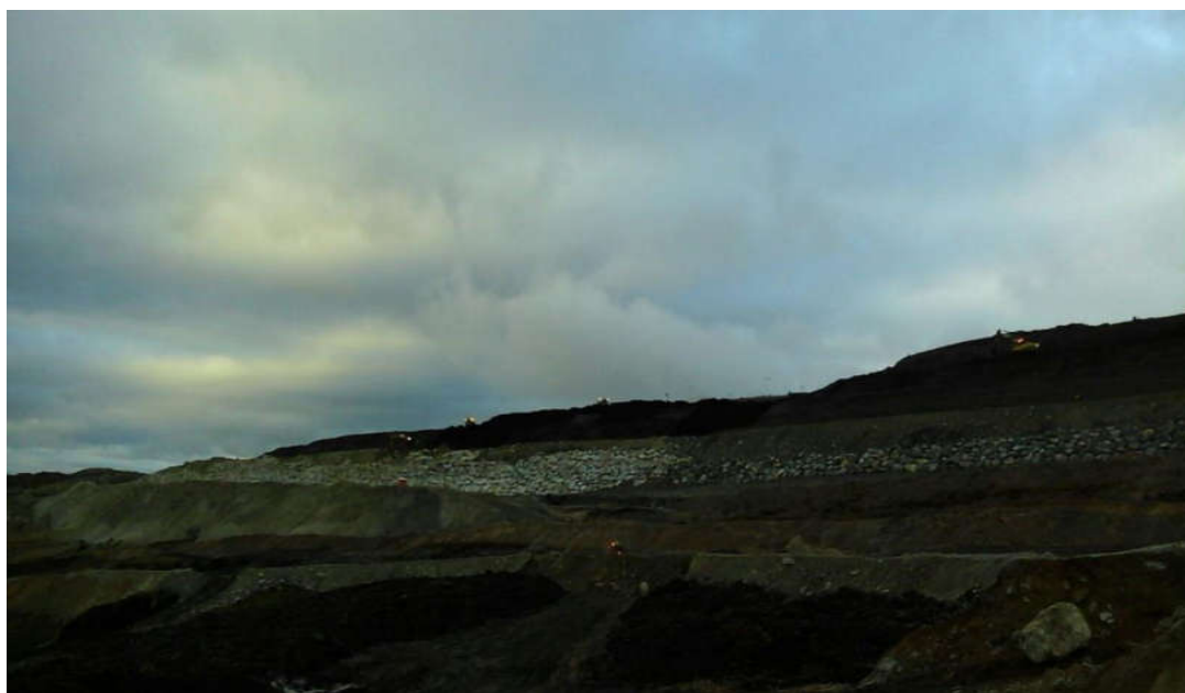
Imagen 13. Dique de depósito de material orgánico en botadero ferrobamba
