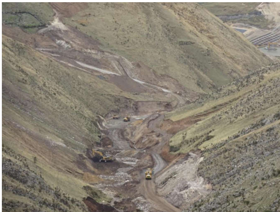
Imagen 26. Vista de eliminación de material inadecuado en la proyección de subdren P-04
