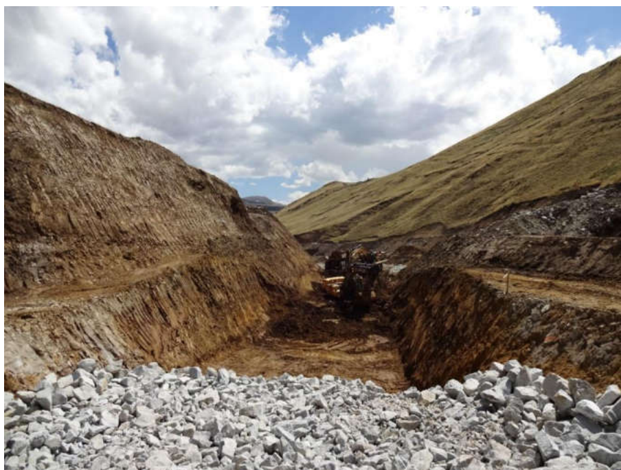
Imagen 25. Subdren principal P-04 del Botadero Ferrobamba
