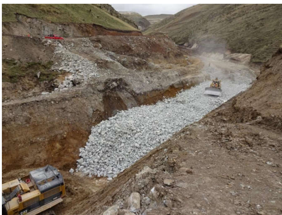
Imagen 27. Enrocado de subdren P-04 Botadero Ferrobamba
