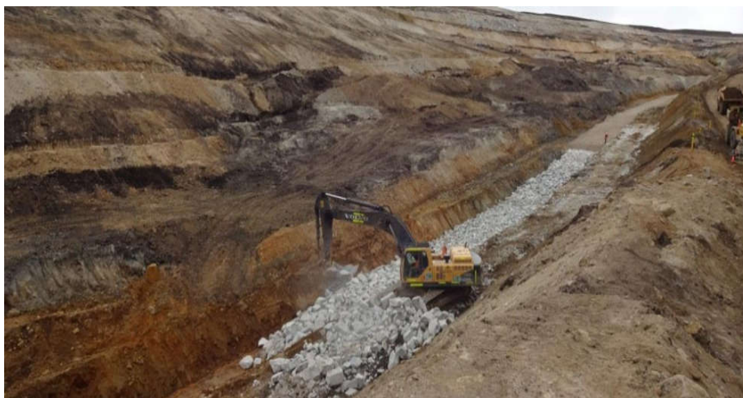
Imagen 10. Subdren secundario S-2 en Botadero Ferrobamba
