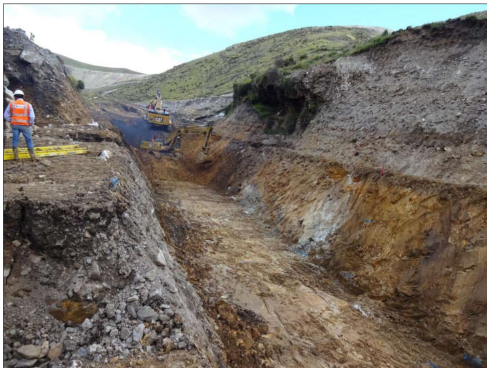
Imagen 19. Excavadora 390D L Excavación de caja de subdren y carguío de material de corte a camiones 740B
