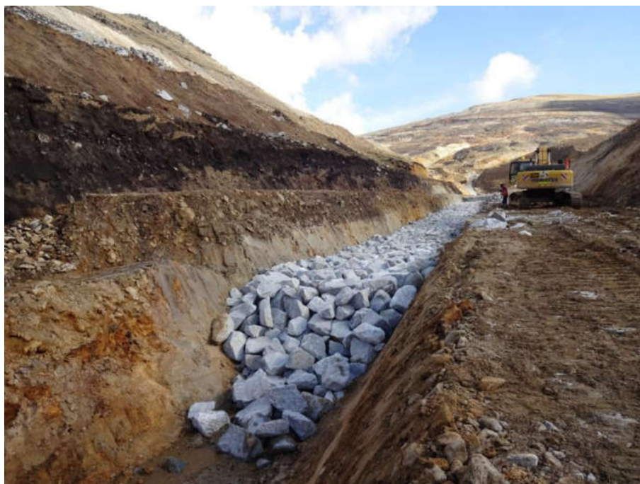
Imagen 22. Subdren P-01 en Botadero Ferrobamba.
