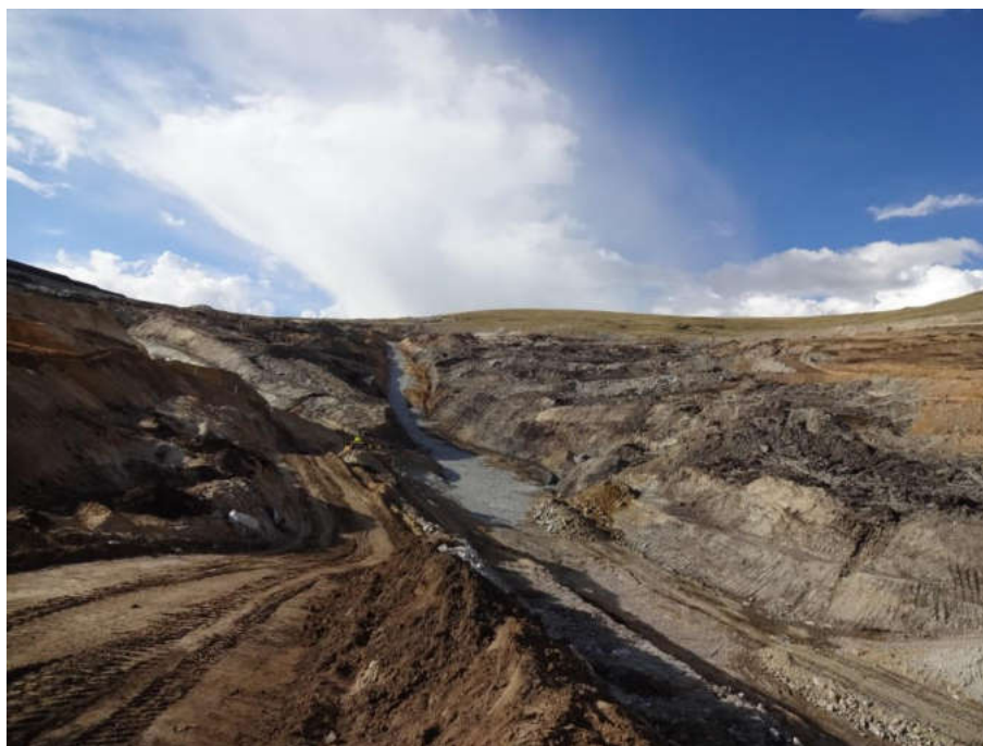
Imagen 24. Subdren secundario S-03 en Botadero Ferrobamba
