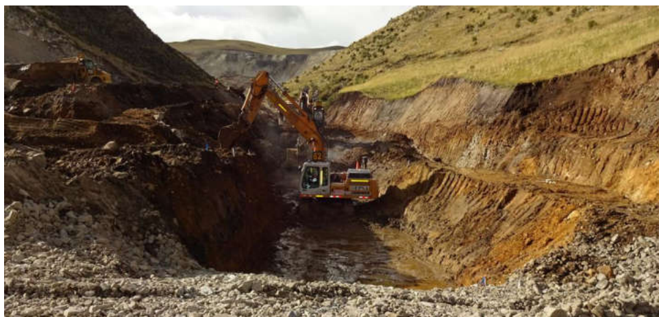
Imagen 17. Detalles de las actividades de excavadoras hidráulicas 336D L y 390D L en subdren. Fuente: (Autor de tesis)
