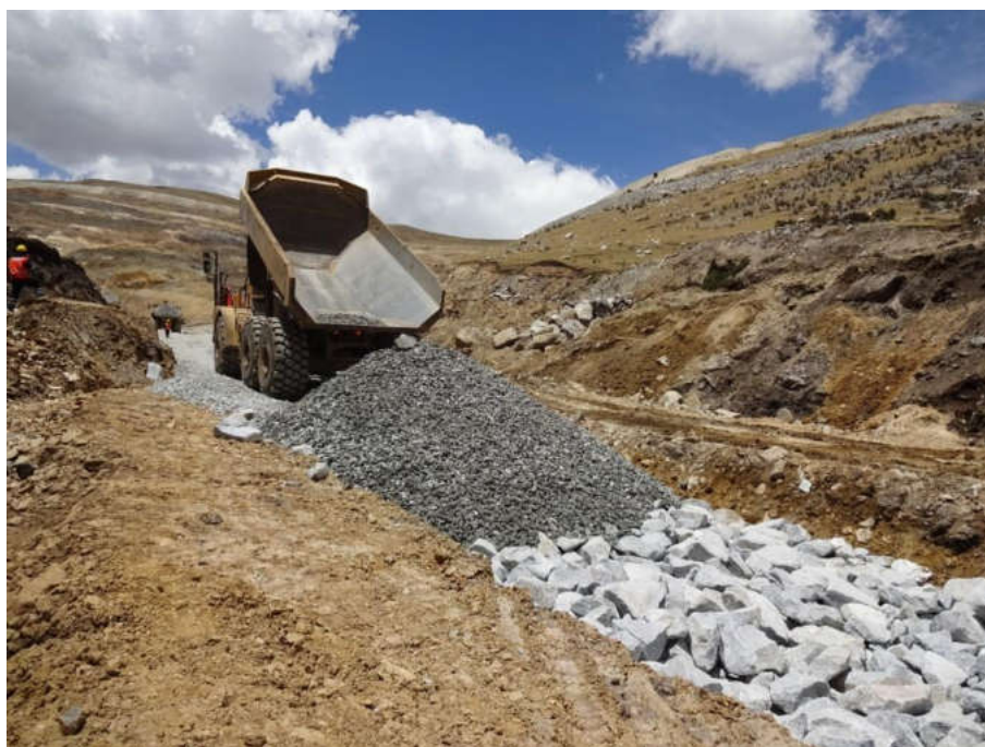
Imagen 23. Subdren principal P-01. Tapado con material filtro.
