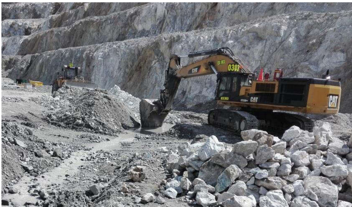
Imagen 3. Excavadora hidráulica de orugas CAT 390 DL
