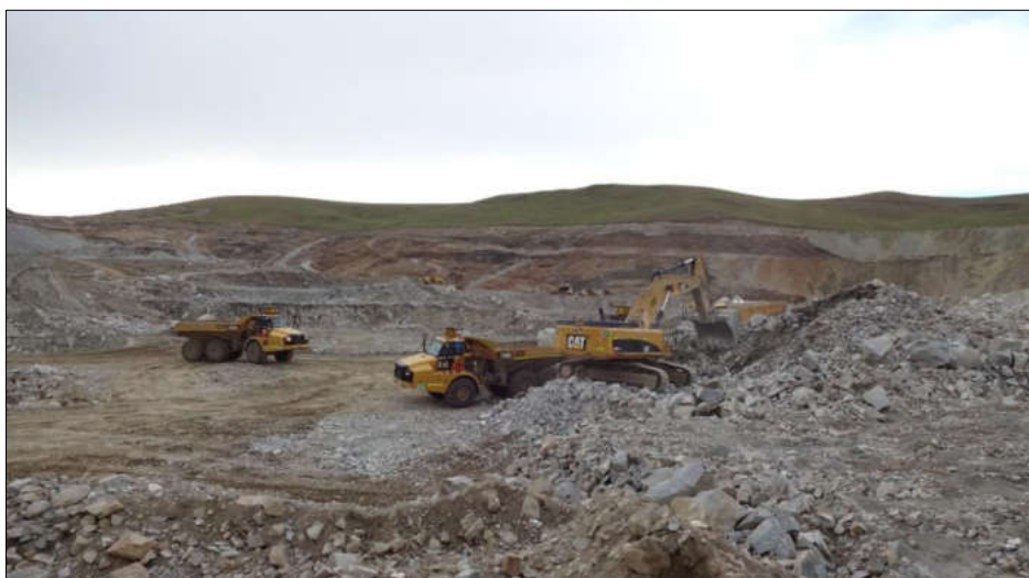
Imagen 18. Excavadora 390D L carguío de material drenante a camiones articulado 740B para relleno controlado en subdren P04
