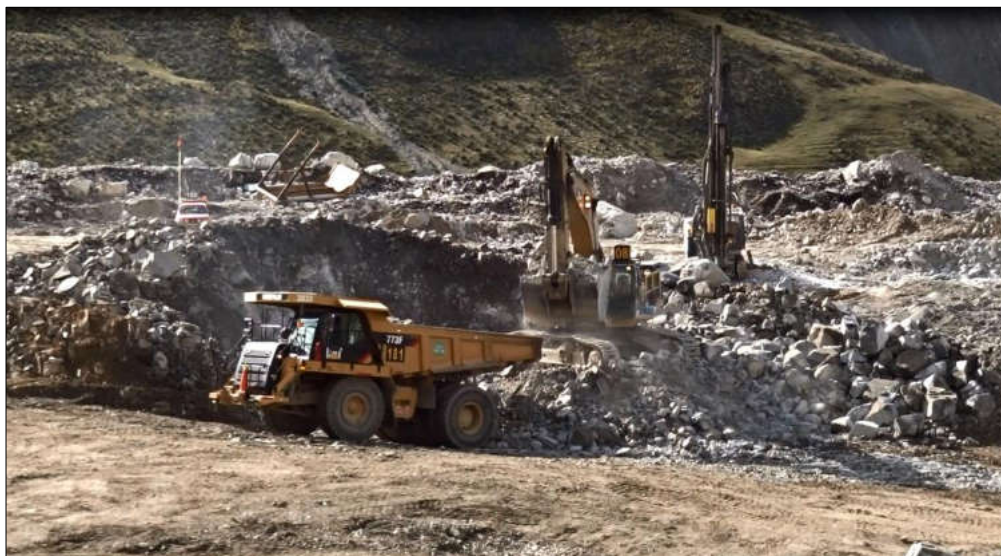
Imagen 20. La excavadora 390D, Carguío de material drenante en cantera.
