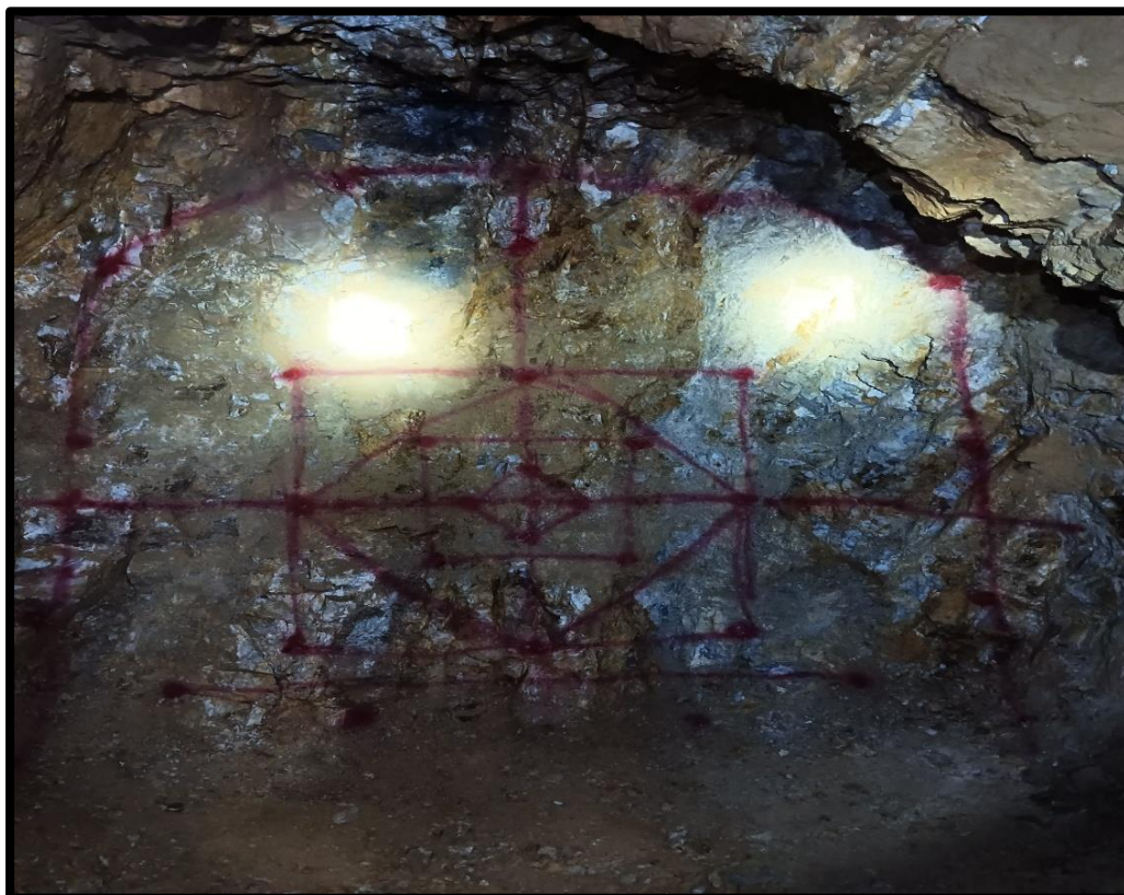
Figura 27 — Trazo del diseño de malla 01 en la galería 4139N.
