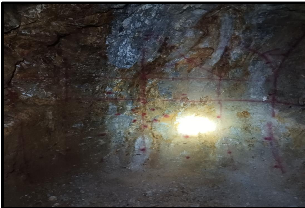
Figura 31 — Trazo del diseño de malla 02 en la galería 4139N.
