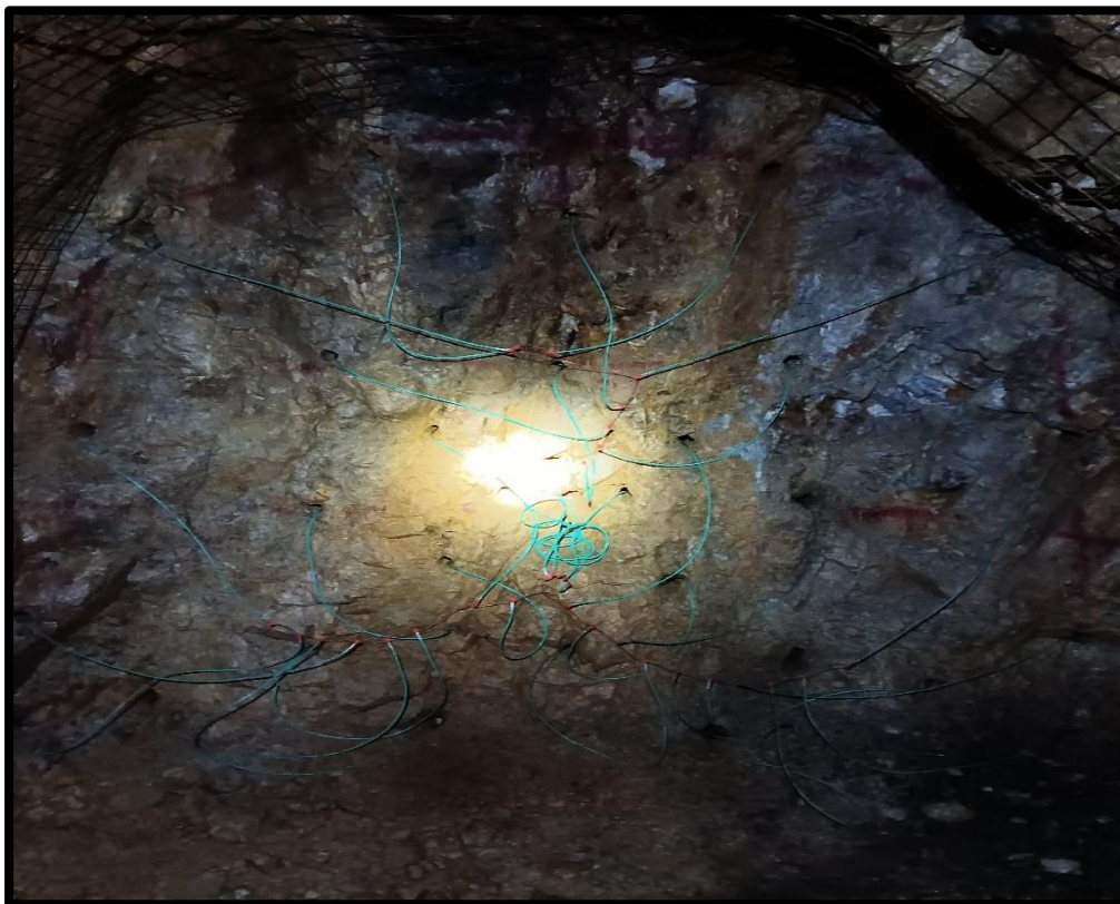
Figura 29 — Galería 4139N con el carguío de taladros en la malla 01.
