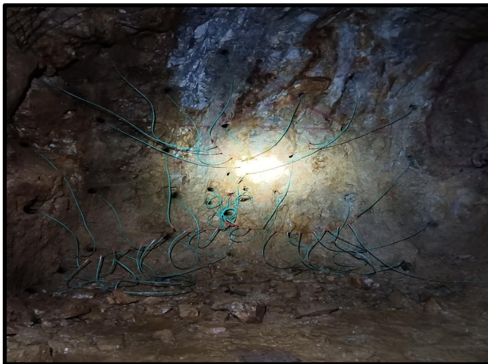
Figura 32 — Galería 4139N con el carguío de taladros en la malla 02.
