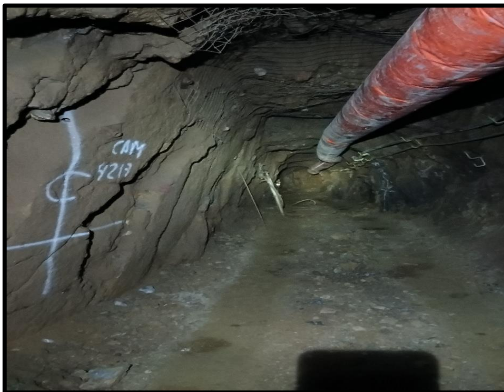
Figura 34 — Galería 4139N con sección controlada después de la estandarización.
