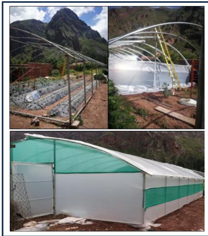
Figura 16 — Instalación de la cubierta del fitotoldo
