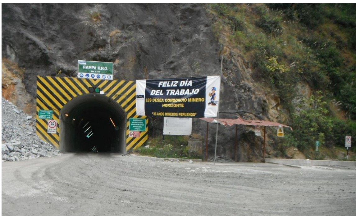
Fotografía N° 05. Rampa de Ingreso a la Mina Lourdes, Zona norte, NV 2285 y 2350
