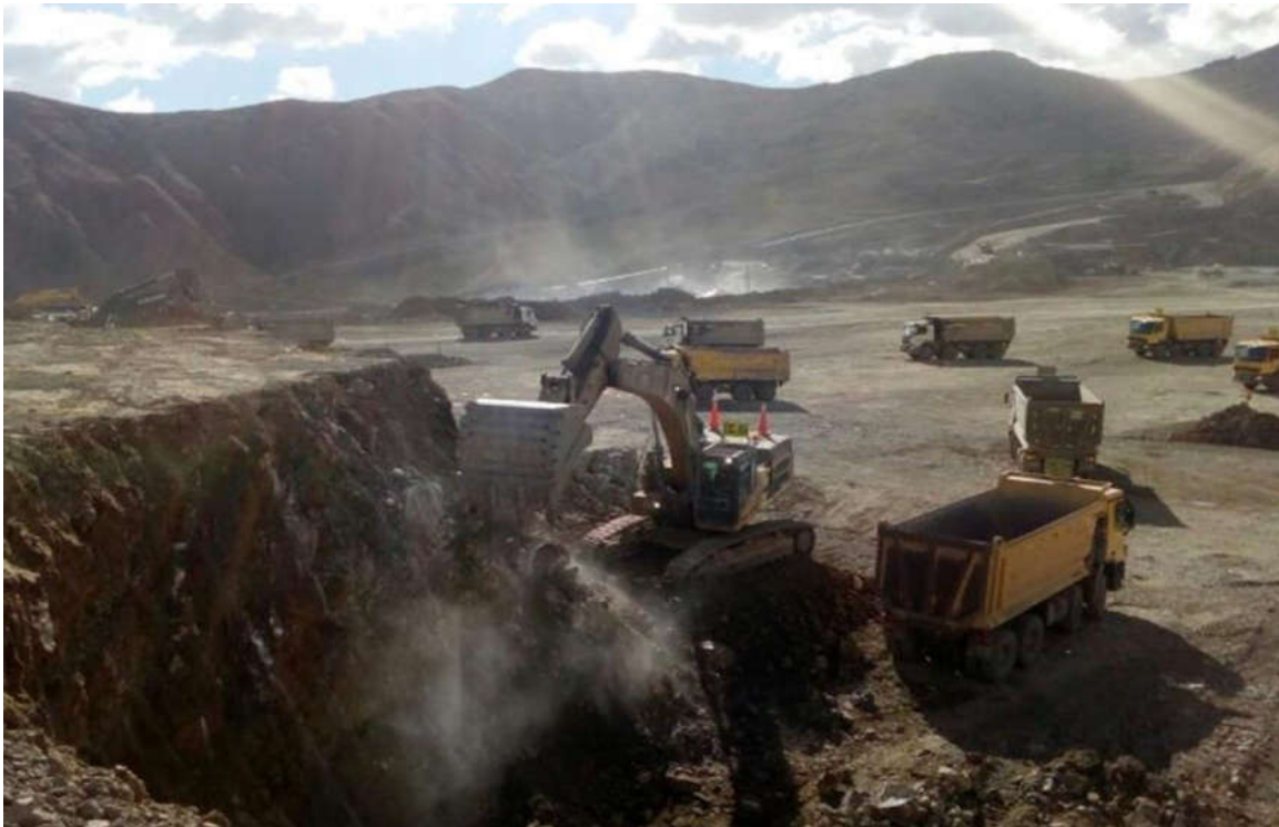
Figura N° 22: Camión de 22.5m 3 siendo cargado de material tipo 3 en Cantera.
