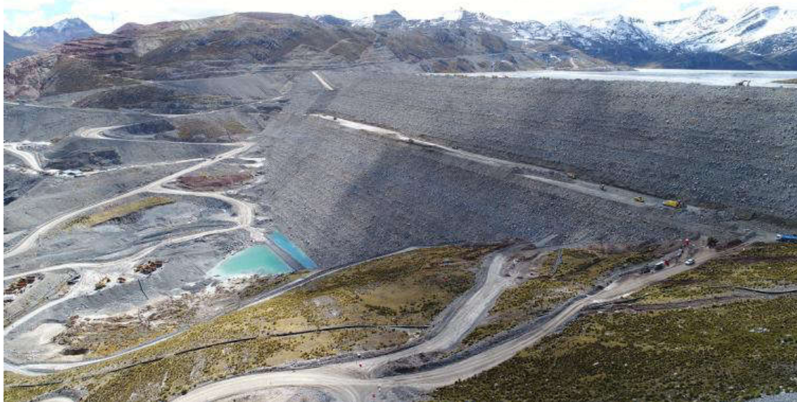
Figura N° 47: Vista en perfil de la tercera etapa de la presa de relaves
