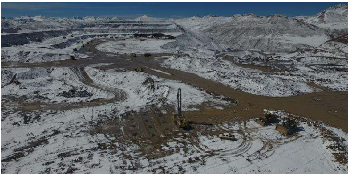
Figura N° 39: Zona de Voladura - Cantera
