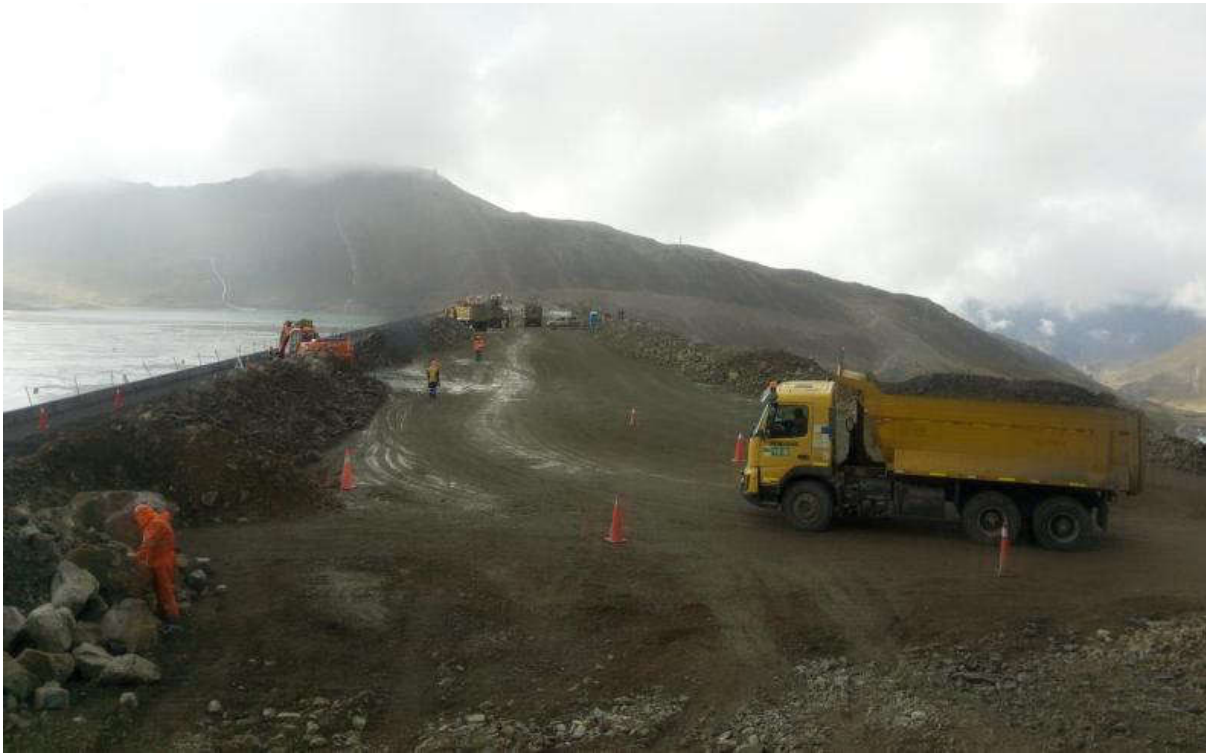
Figura N° 21: Camión de 17m 3 transportando material tipo 3A Presa de Relave
