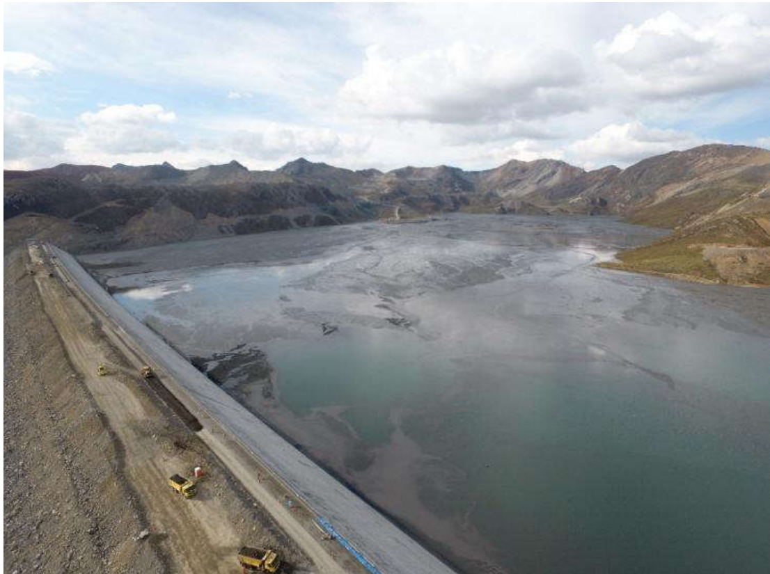
Figura N° 6: Relave Minero en la presa – Etapa III
