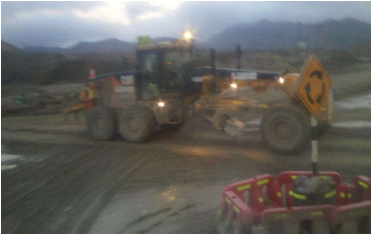
Figura N° 31: Motoniveladora CAT 140M realizando trabajos de mantenimiento de Vías.
