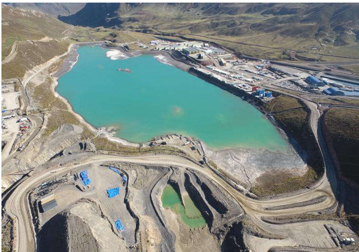
Figura N° 50: Agua filtrada de la presa de relaves
