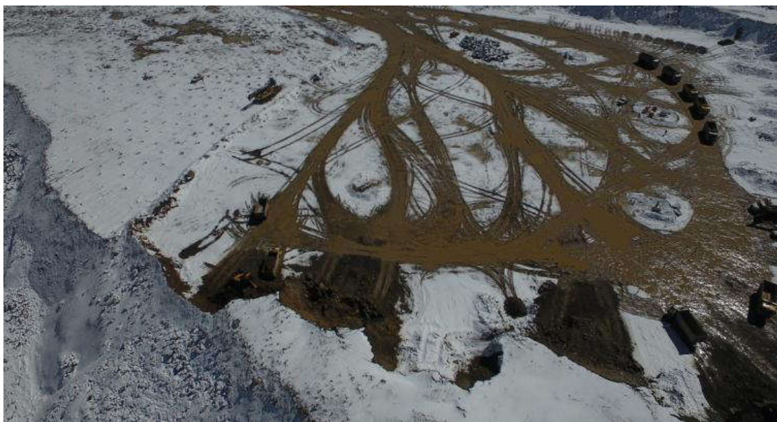
Figura N° 41: Frentes de Trabajo de las Excavadoras
