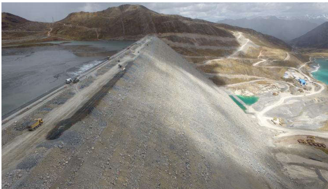
Figura N° 43: Conformación de la cresta
