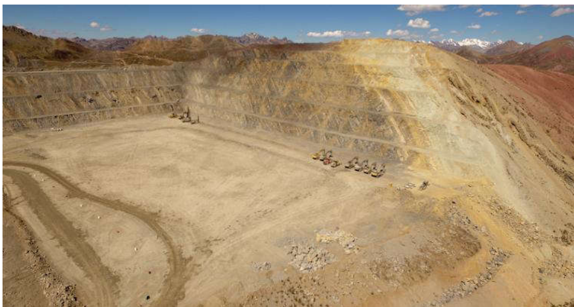
Figura N° 45: Zona de Parqueo de las Excavadoras
