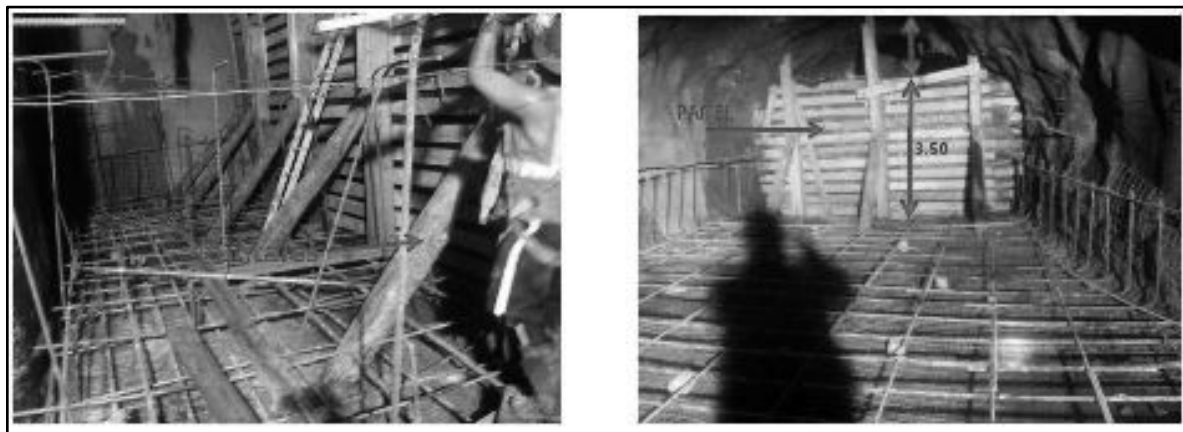
Figura Nro. 14: Encofrados o Tabique actual de las losas
