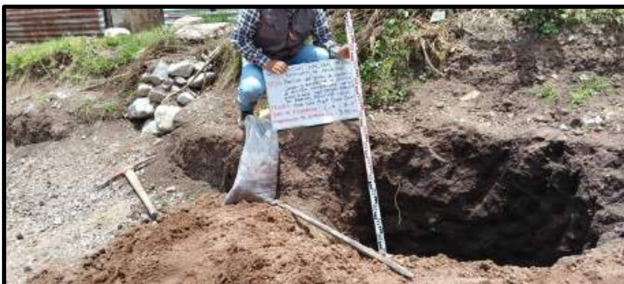
Figura 103 — Excavación de calicata C-04
