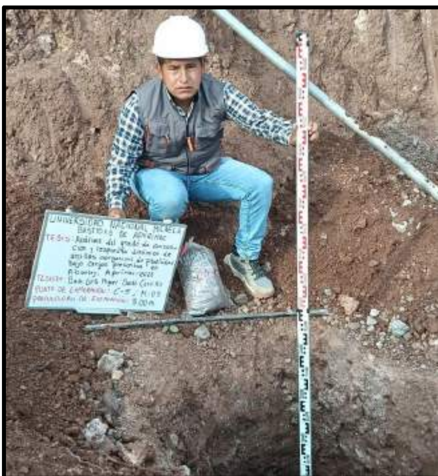
Figura 104 — Excavación de calicata C-05
