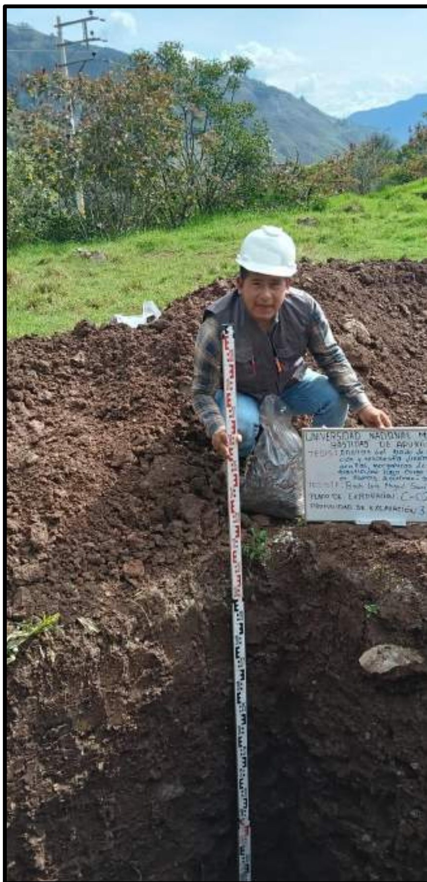
Figura 101 — Excavación de calicata C-02
