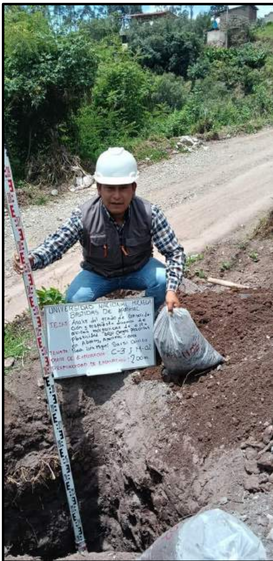
Figura 102 — Excavación de calicata C-03
