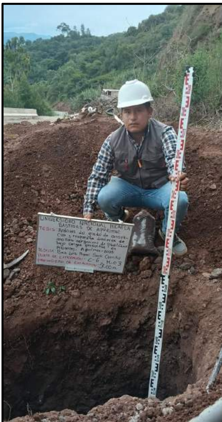
Figura 105 — Excavación de calicata C-06
