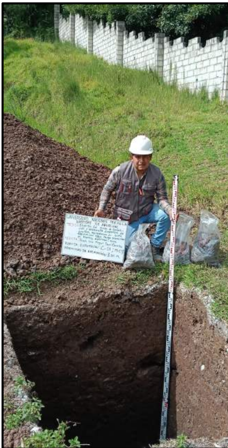
Figura 100 — Excavación de calicata C-01
