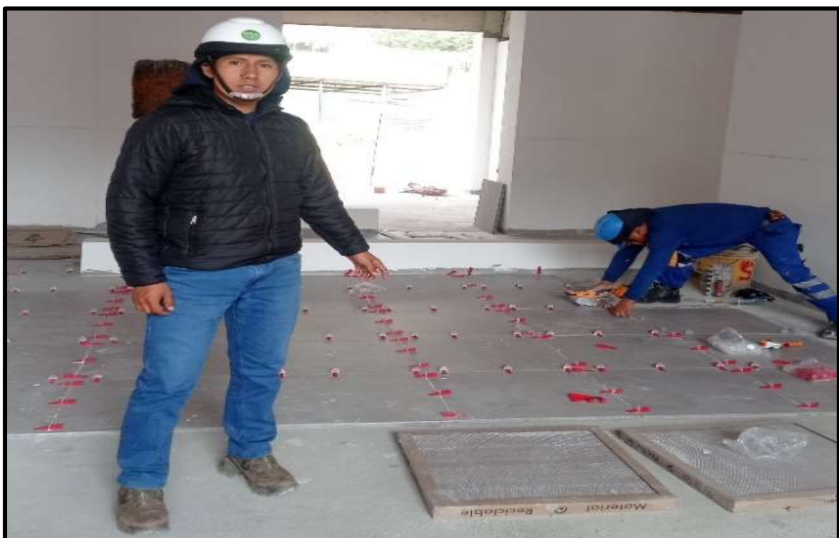
Figura 37 — verificación de enchapados de la cuadrilla N°04
