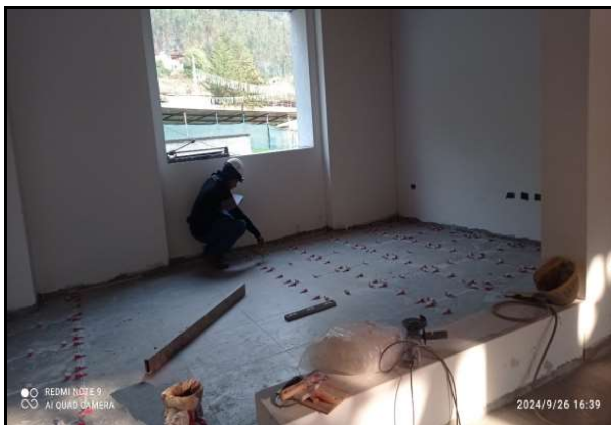
Figura 30 — Medición de las áreas respecto al avance diario en la OFIC. DE SECRETARIA TÉCNICA
