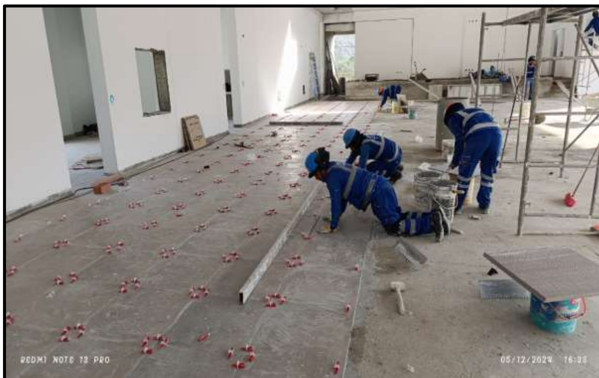
Figura 42 — Anotación del rendimiento y Verificación de enchapados de las cuadrillas N°06,07 y 08 en el AUDITORIO, mostrándose el enchapado de porcelanatos enteros sin cortes.
