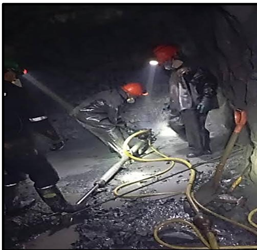
Figura 29 — preparación para la perforación en la cortada principal
