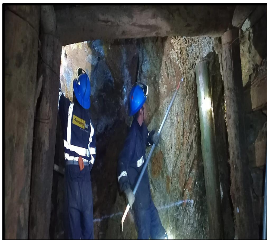
Figura 32 — Preparación de sostenimiento con cuadros de madera
