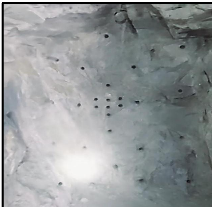
Figura 30 — Malla de perforación
