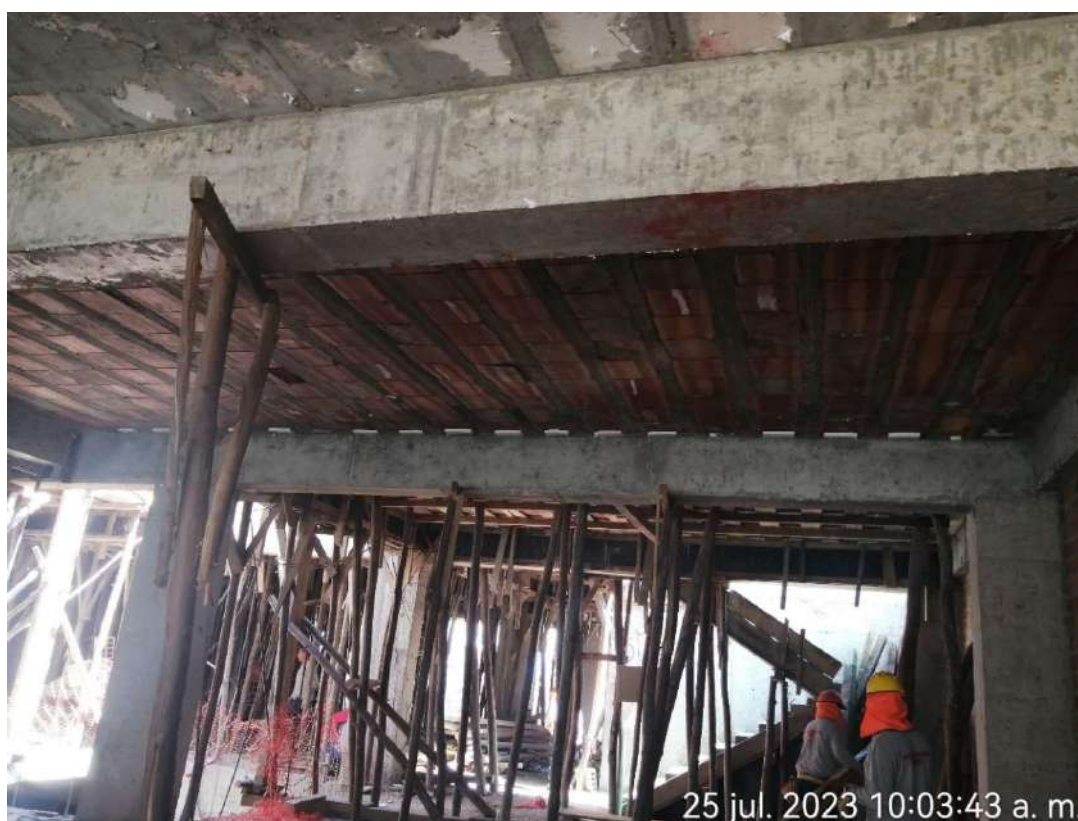
Figura 54 — Desencofrado en vigas y losa del 3er nivel
