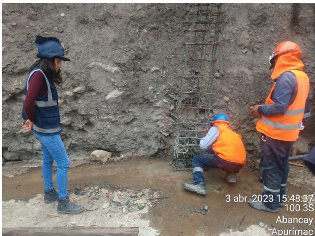
Figura 30 — Verificación de trazado para encofrado en columnas de sótano
