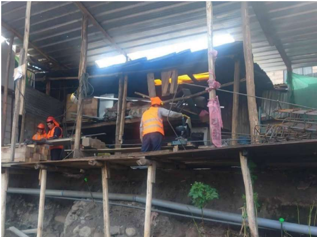
Figura 25 — Habilitación de acero de refuerzo para columnas
