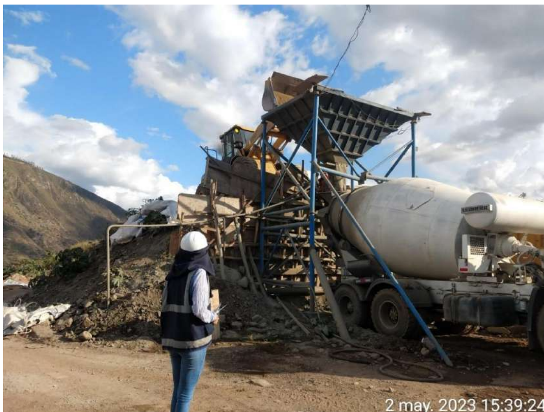
Figura 48 — Concreto premezclado en planta concretera
