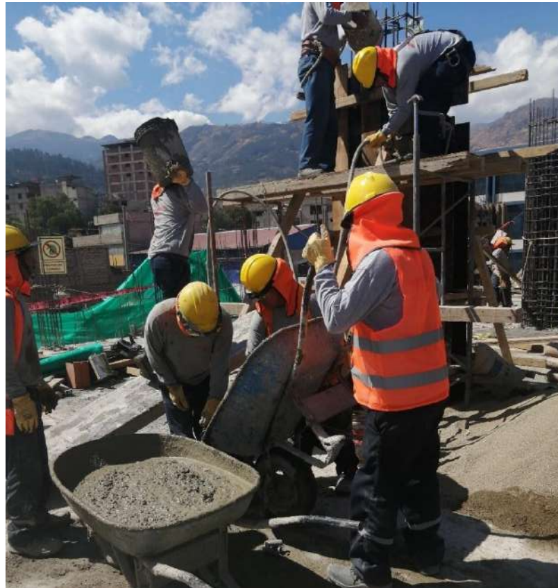
Figura 57 — Vaciado de concreto en columnas del 4to nivel
