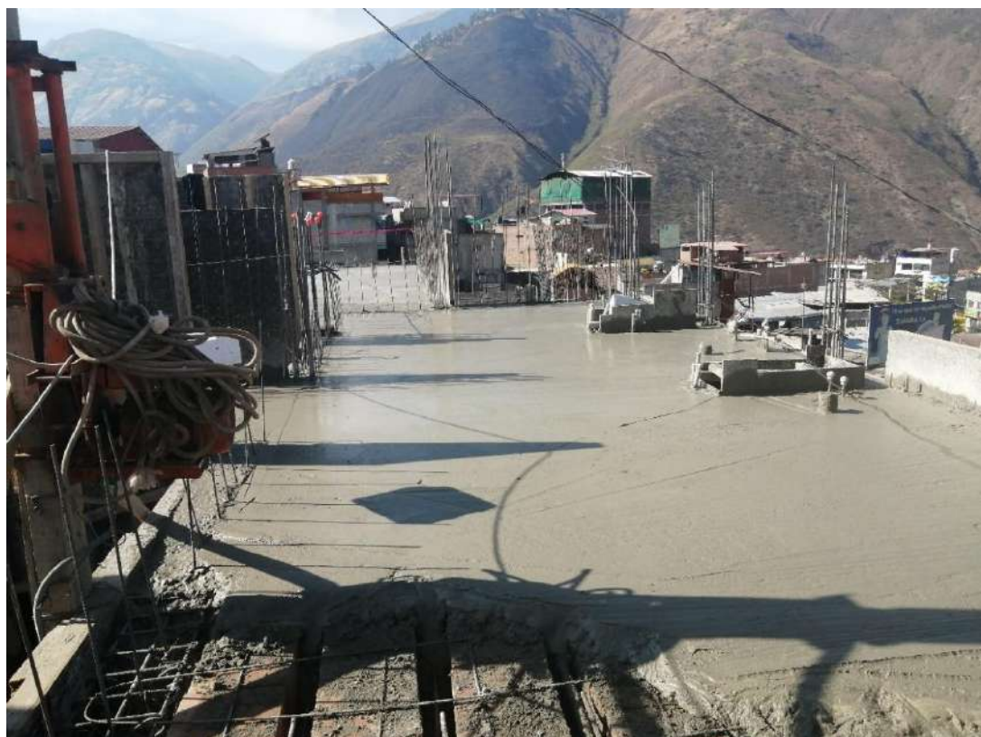
Figura 58 — Vaciado de concreto en vigas y losa del 4to nivel
