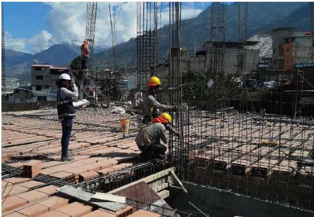
Figura 50 — Toma de datos en acero de refuerzo de columnas del 3er nivel
