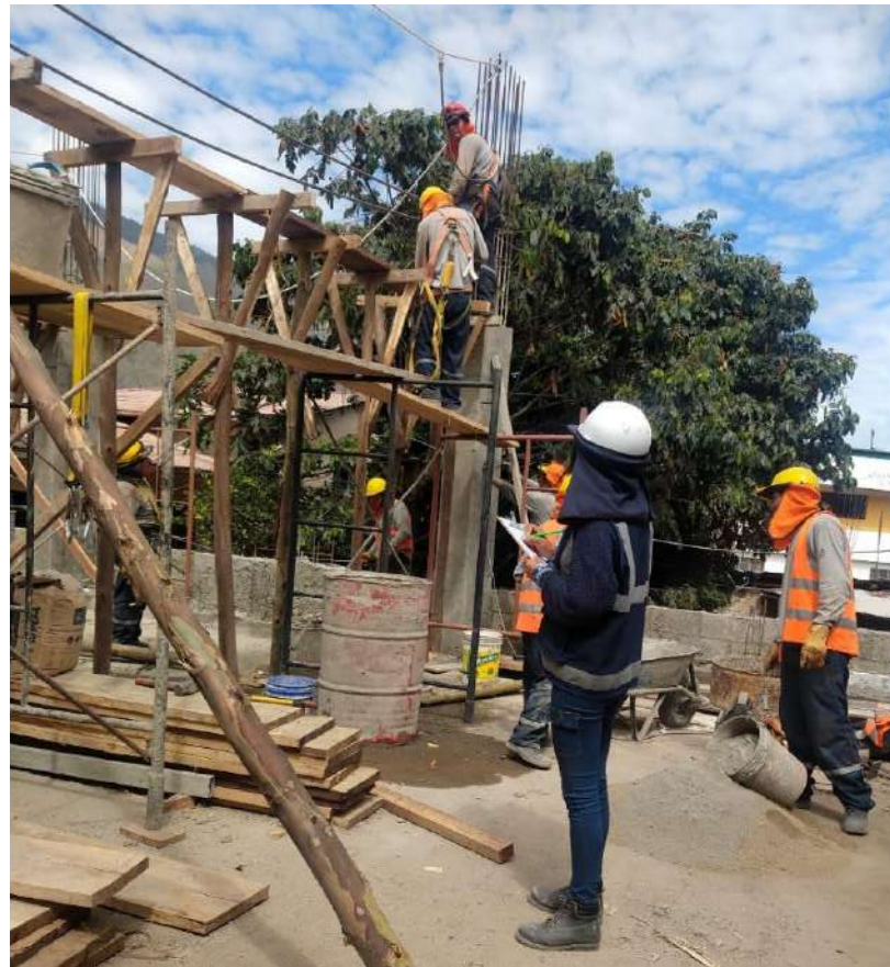
Figura 41 — Encofrado en vigas del 1er nivel
