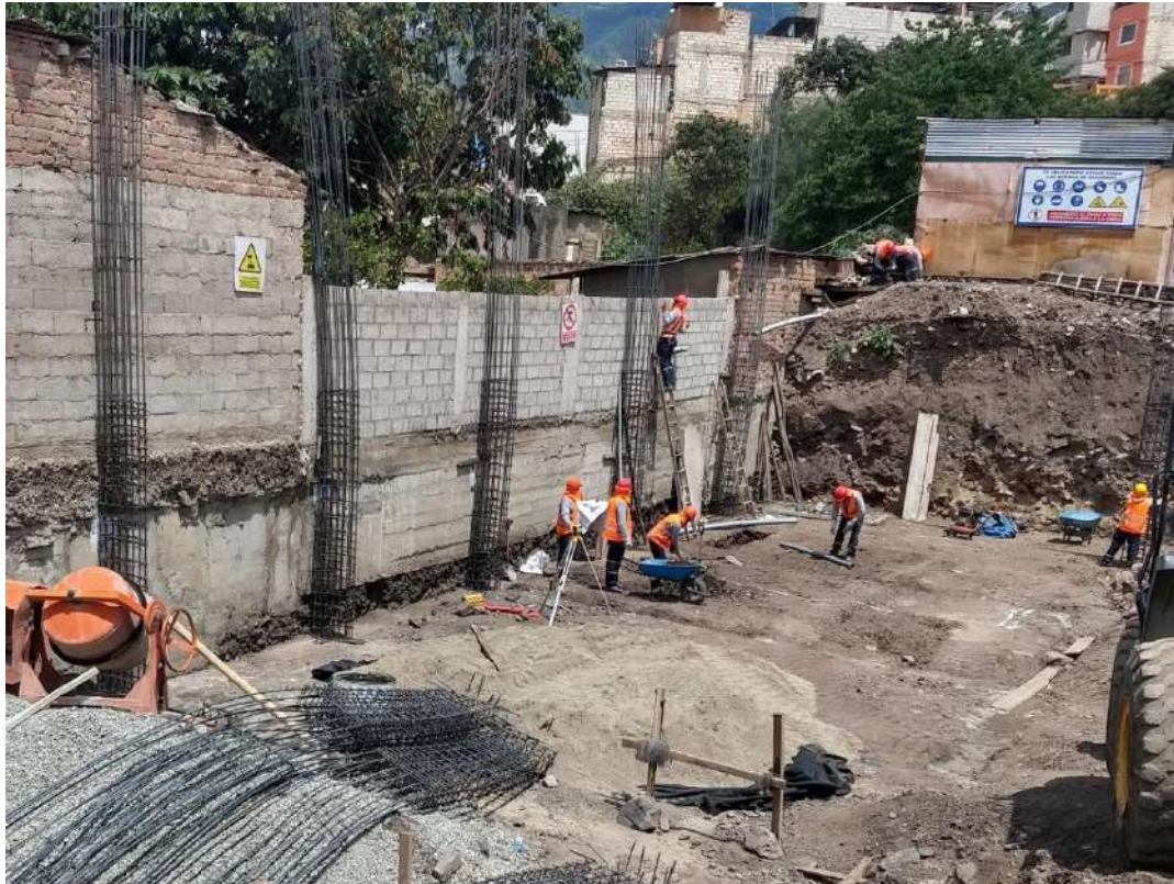
Figura 27 — Izado de columnas en sótano
