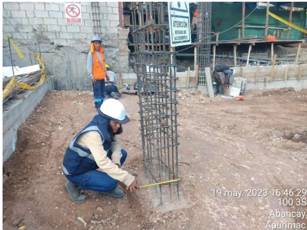
Figura 39 — Verificación de medidas de estribos en columna del 1er nivel
