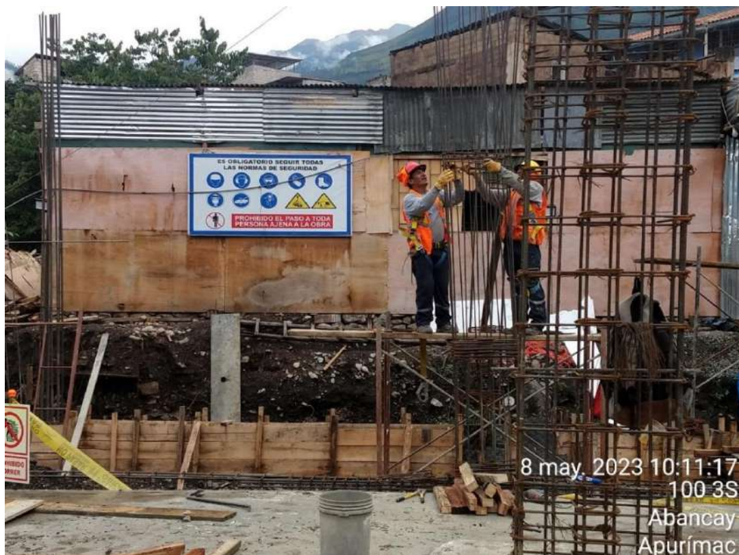
Figura 38 — Armado de acero de refuerzo en columna del 1er nivel
