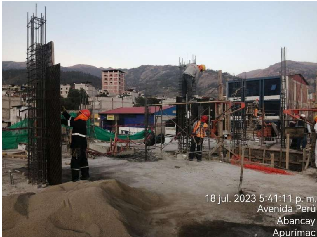
Figura 55 — Armado de acero de columnas del 4to nivel
