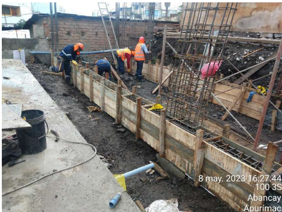
Figura 36 — Encofrado en vigas de cimentación
