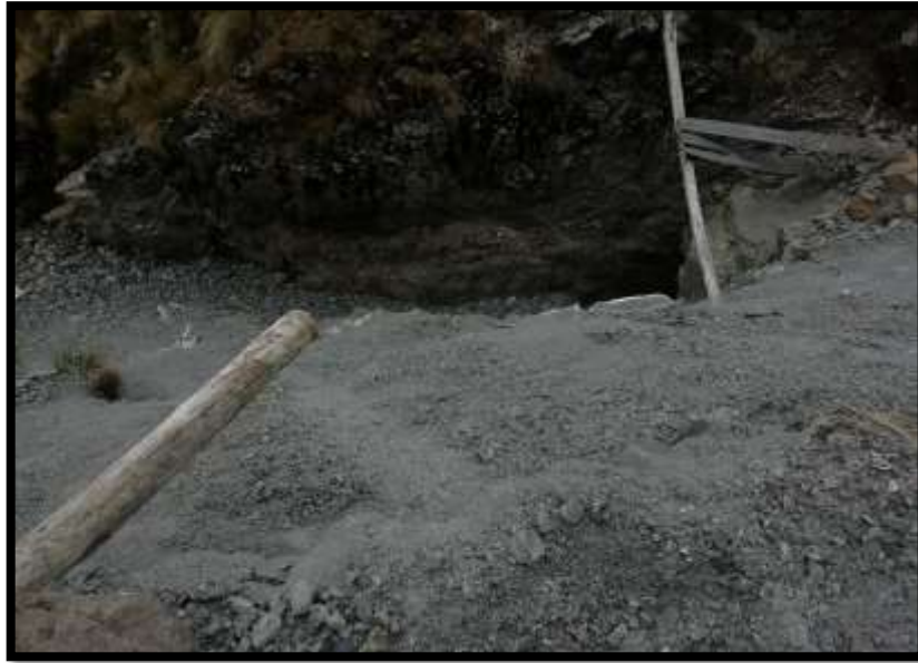
Foto IV-7: Acceso a labor que presenta desprendimiento de material.
