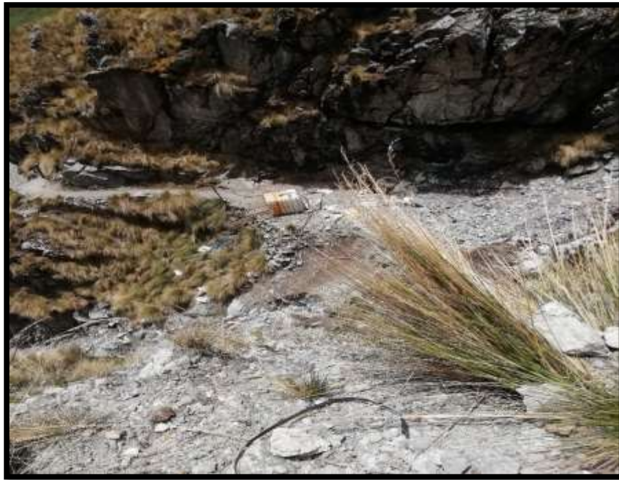
Foto IV-11: Caída de material interfiriendo en el pase en el acceso a la labor.
