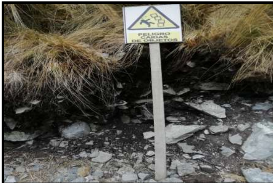
Foto IV-12: Implementando señalización con respecto a caída de objetos.
