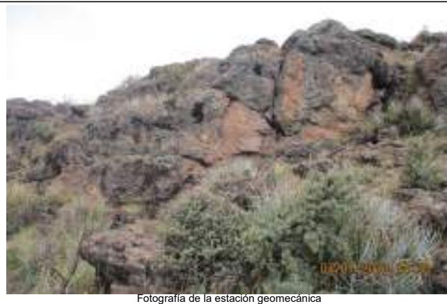
Fotografía de la estación geomecánica
