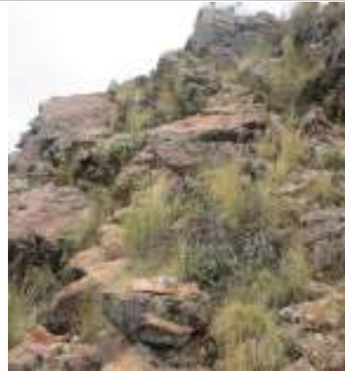
Fotografía de la estación geomecánica
