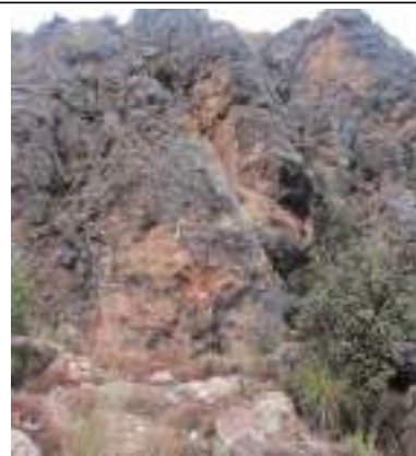
Fotografía de la estación geomecánica
