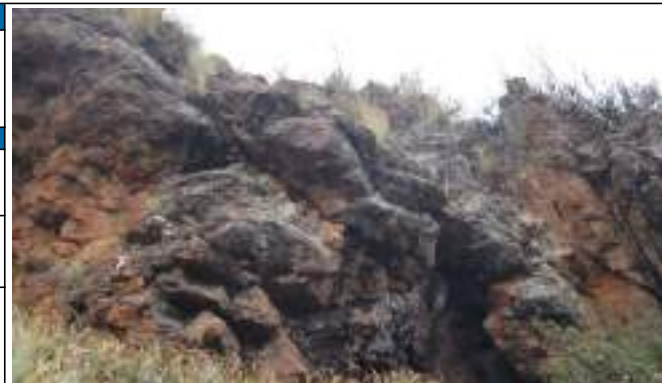
Fotografía de la estación geomecánica
