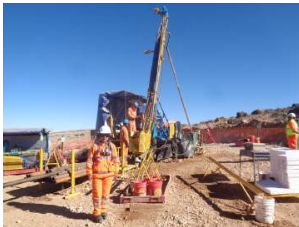
Fotografía N° 2: supervisión de los Taladros Geotécnicos.
