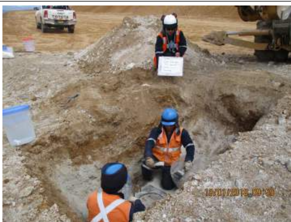
Fotografía N° 5: Ejecución de Calicatas (C-10).
