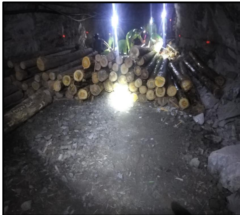
Figura 37— Elaboración de puntales para el sostenimiento.
