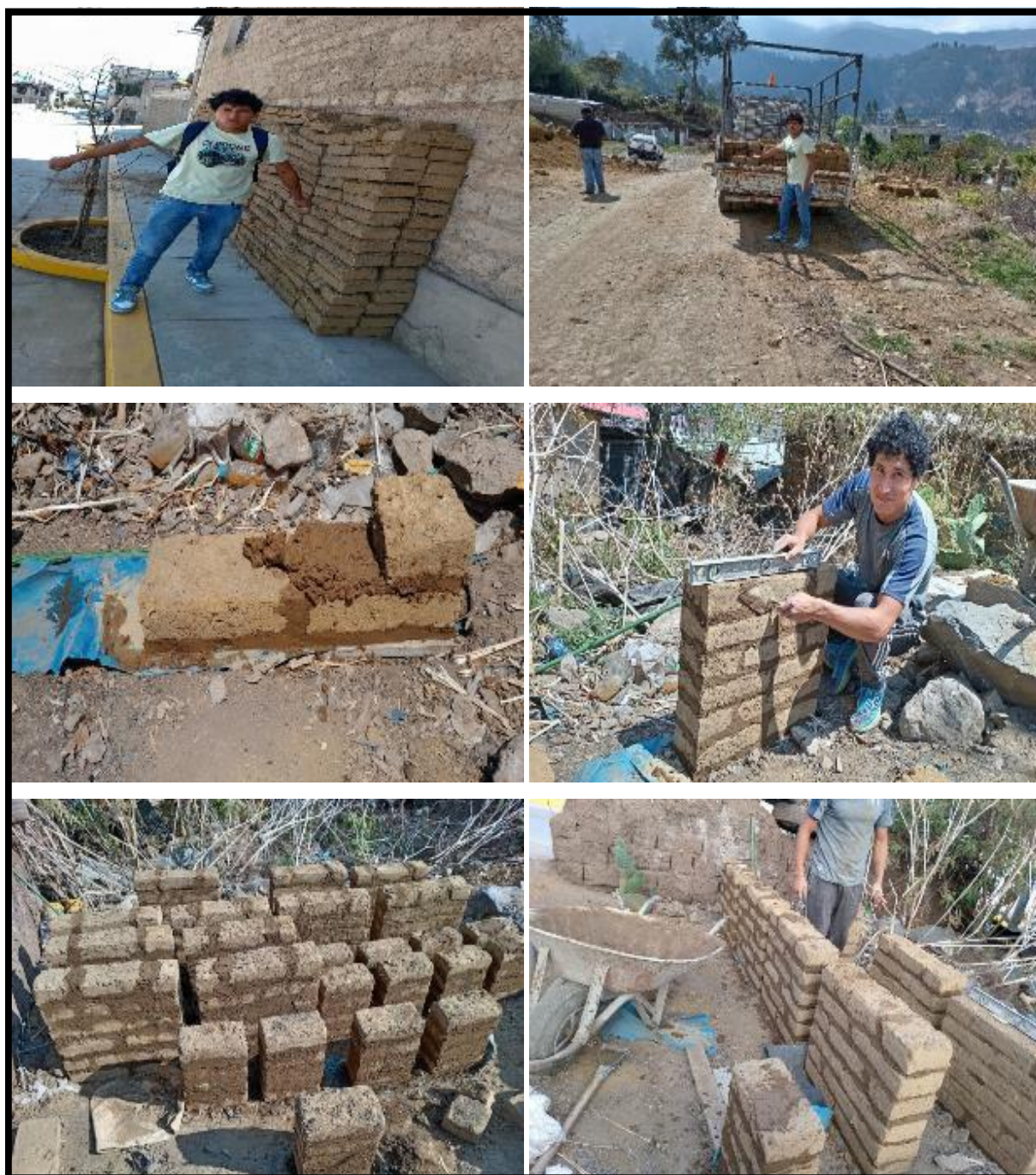
Figura 61 — Elaboración de pilas y proceso de pircado de muretes
