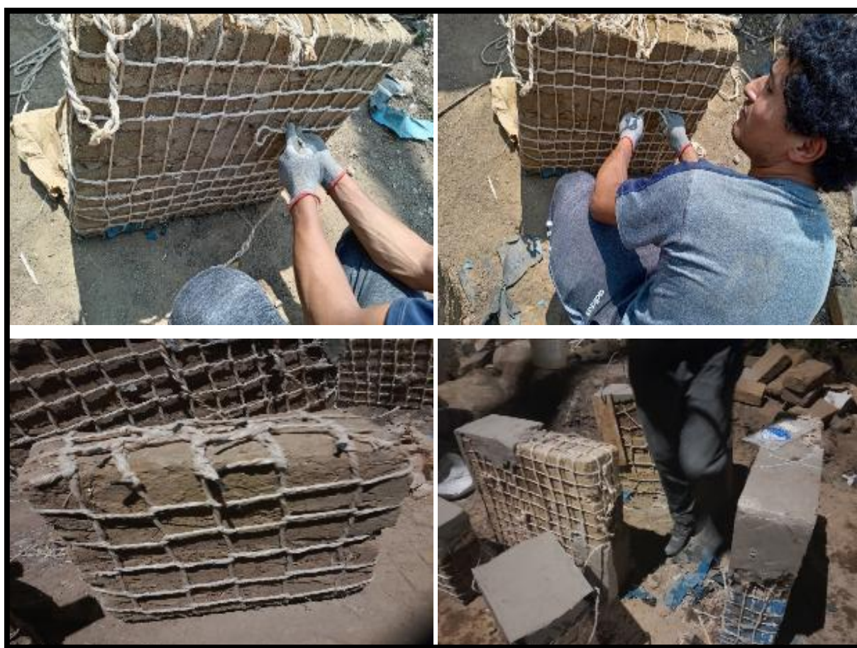
Figura 63 — Proceso de enmallado o reforzamiento de los muretes y pilas con malla de PET
