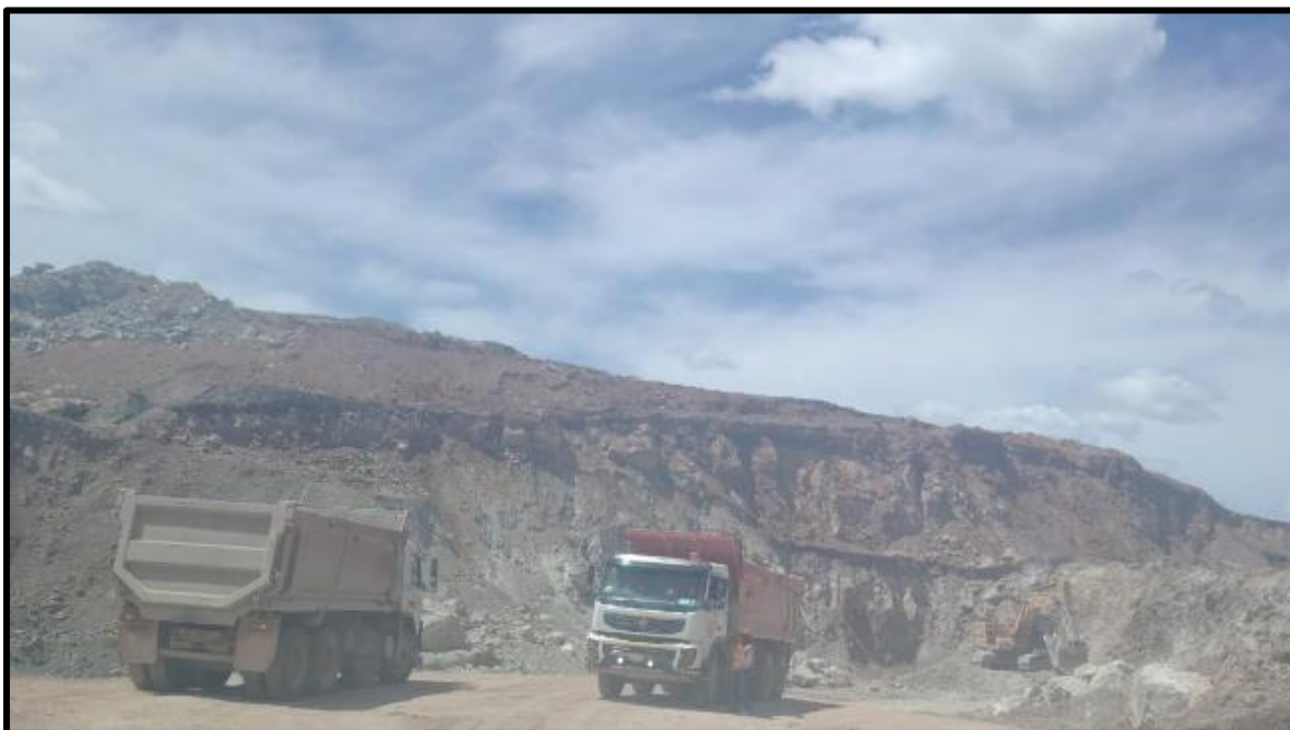
Figura 20 — Acarreo de material volado de los tajos B1 y B2
