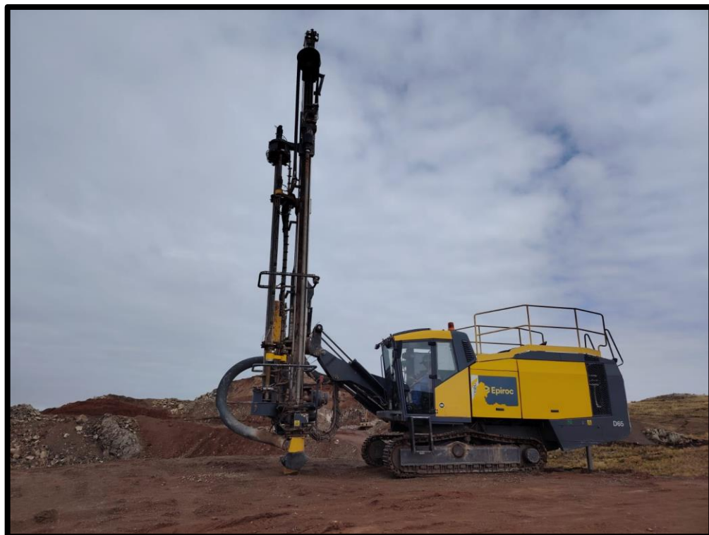
Figura 14 — Equipo de perforación FlexiRoc D65
