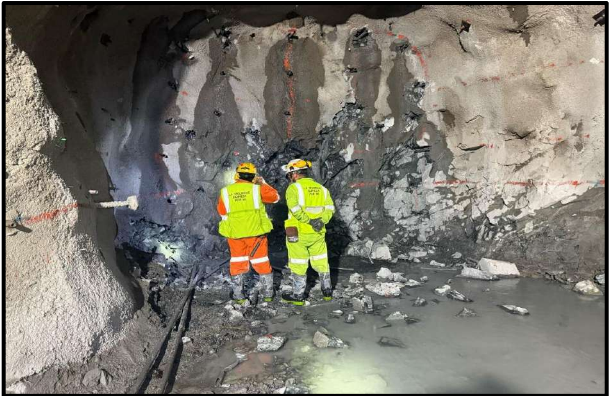
Figura 24 — Inspección del diseño de malla de perforación en el frente de avance
