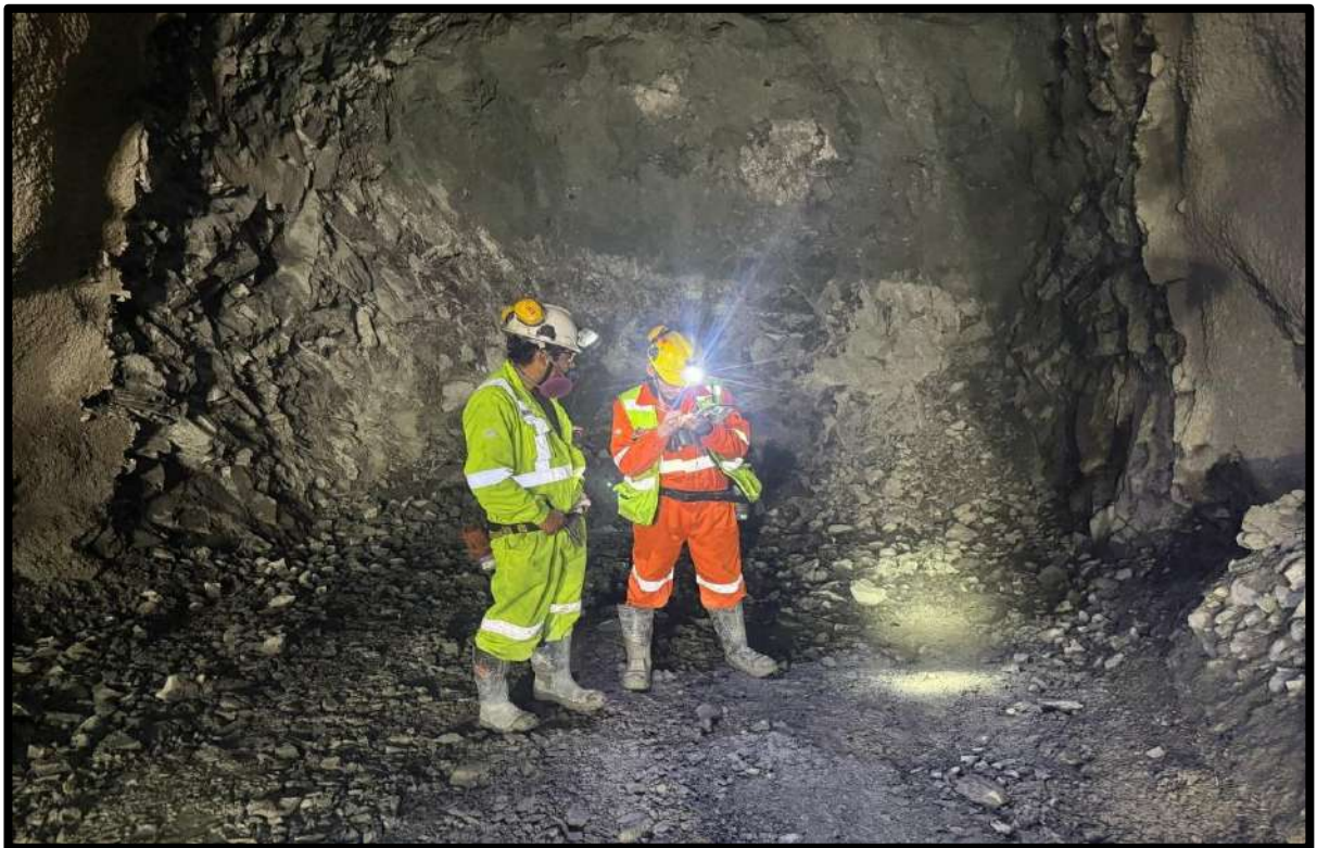
Figura 25 — Recolección de datos para las clasificaciones geomecánicas del macizo rocoso
