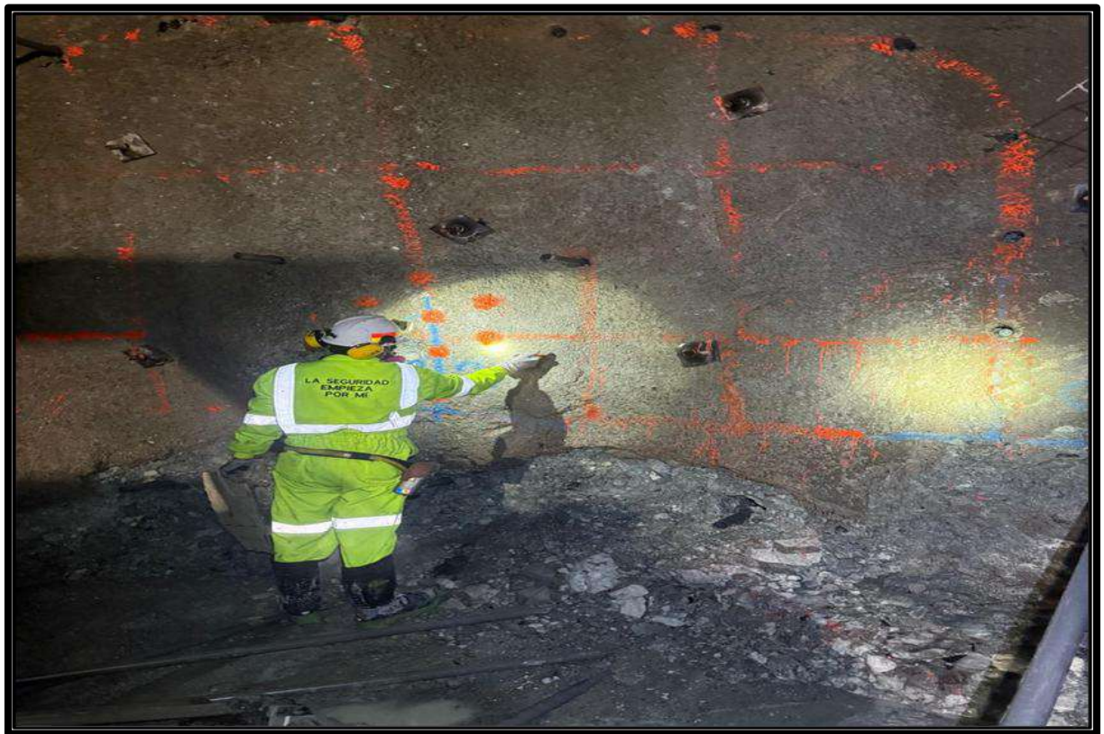
Figura 27 — Diseño de marcado de la malla de perforación
