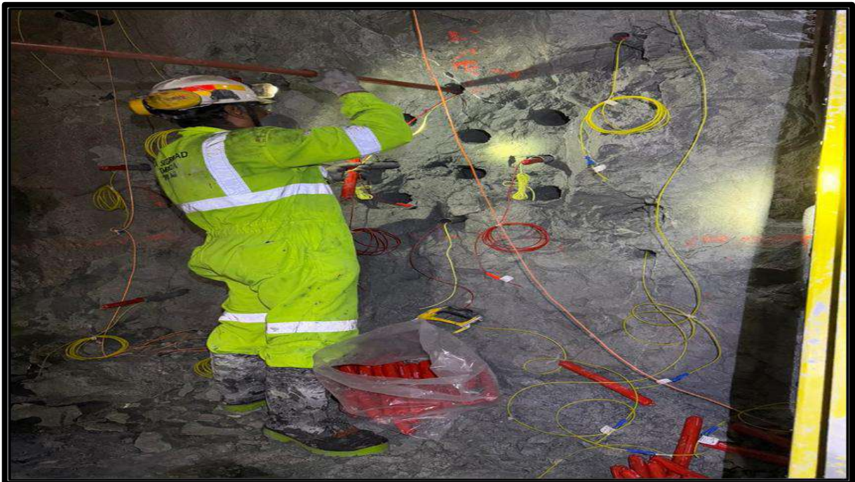
Figura 29 — Carga de explosivos en los taladros perforados
