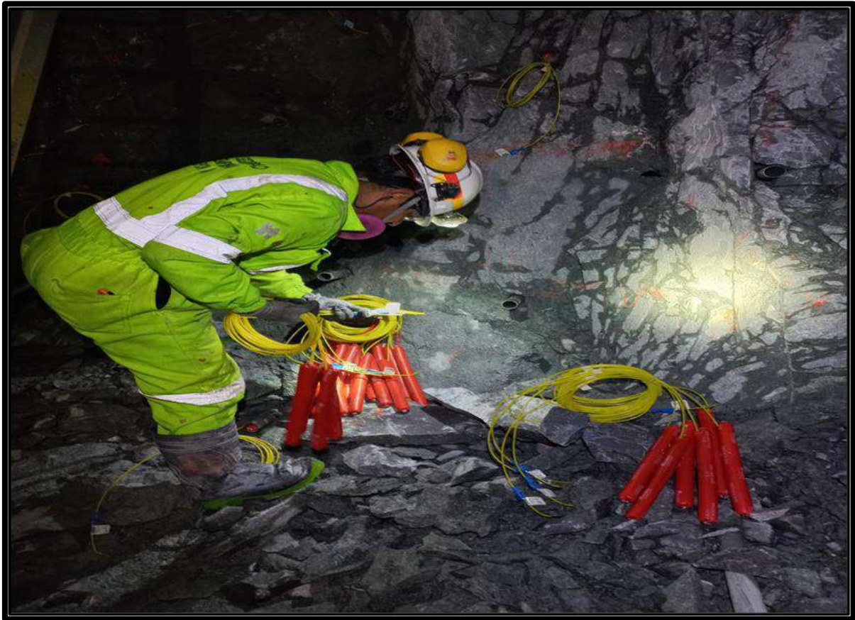
Figura 30 — Preparación de explosivos
