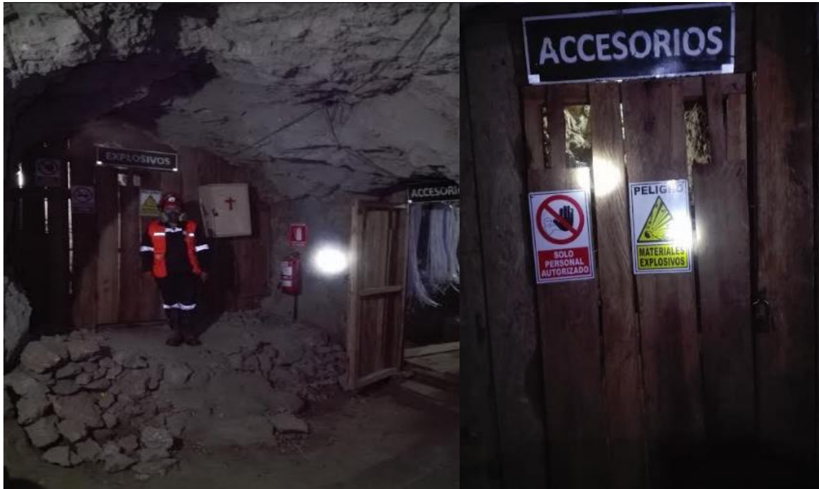
Foto 7: Almacenamiento de explosivos y accesorios para voladura en interior mina.
