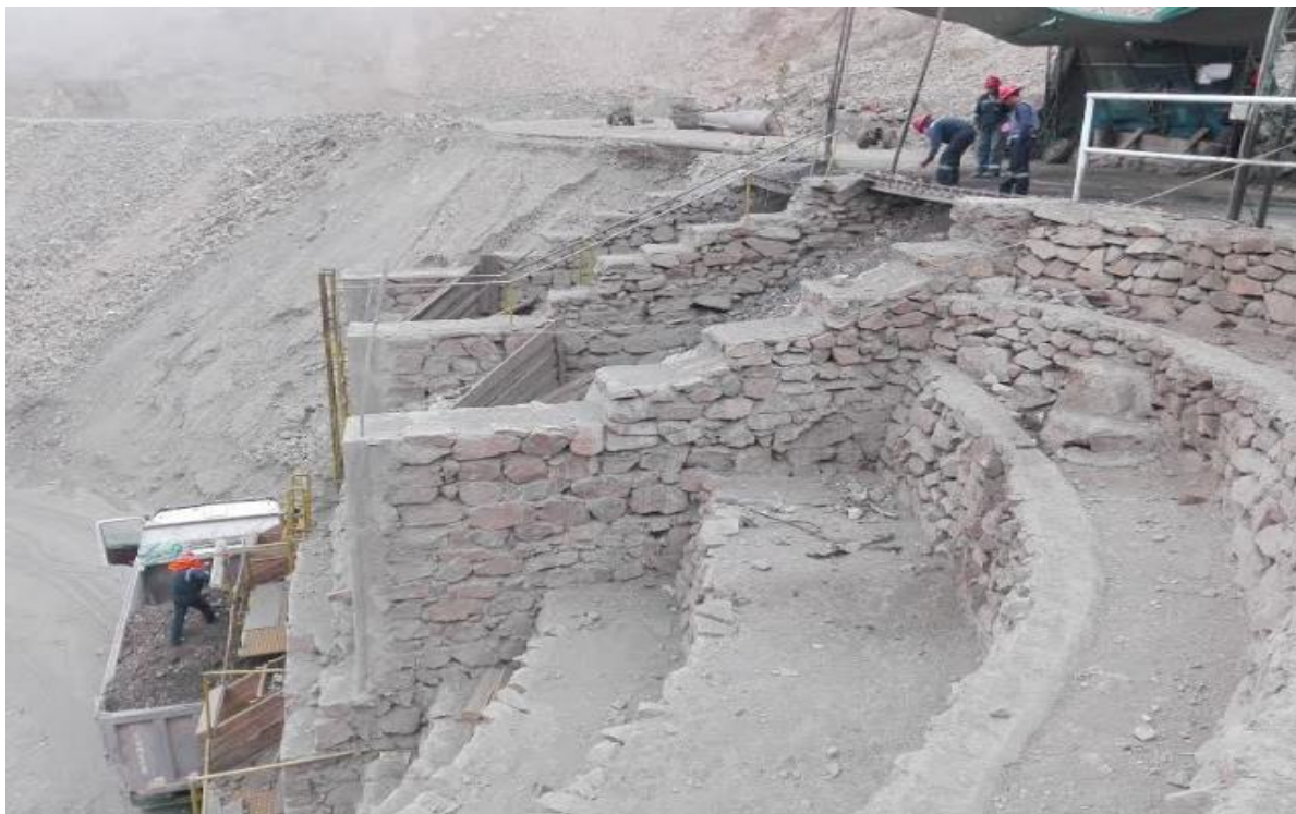
Foto 8: Tolva de acopio, donde se acumula todo el mineral extraído de interior mina mediante los coches mineros, para próximamente ser trasladado por volquetes a las plantas de tratamiento.
