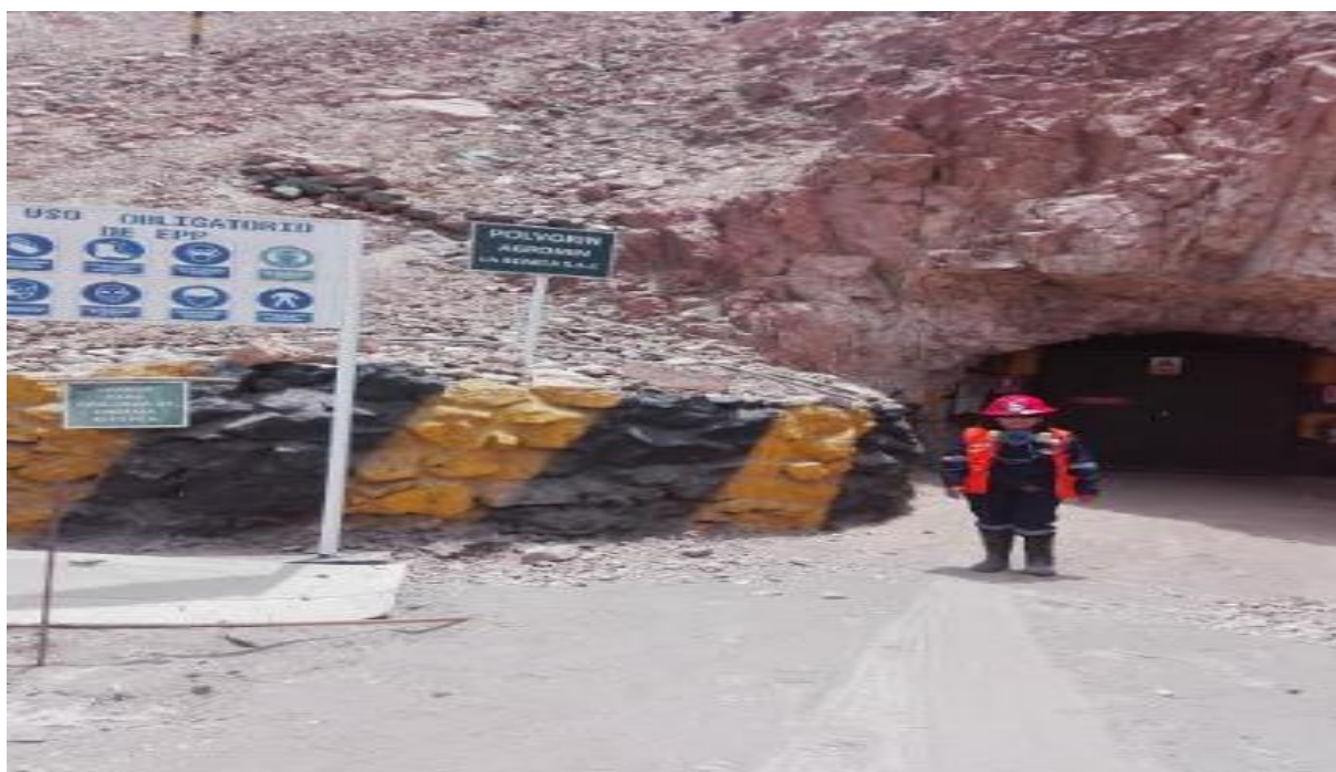
Foto 4: Polvorín de la mina Agromin la Bonita S.A.C.
