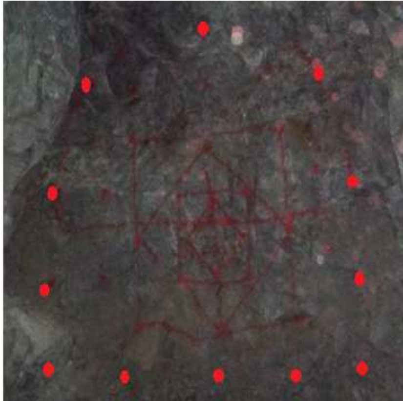
Figura 9. Pintado de malla de perforación
