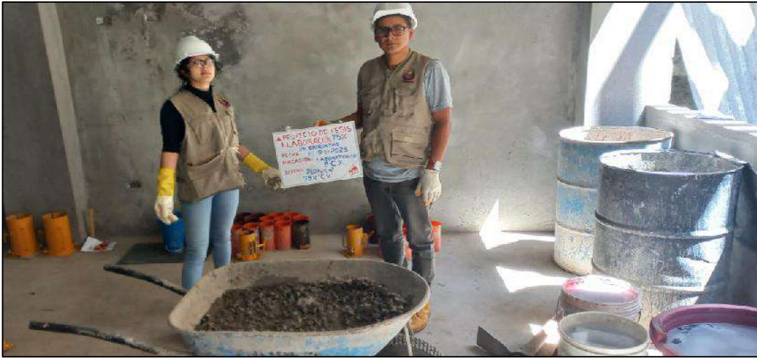
Figura 66 — Preparación manual del concreto f'c=210 \text{ kg/cm}^2 para el G 5
