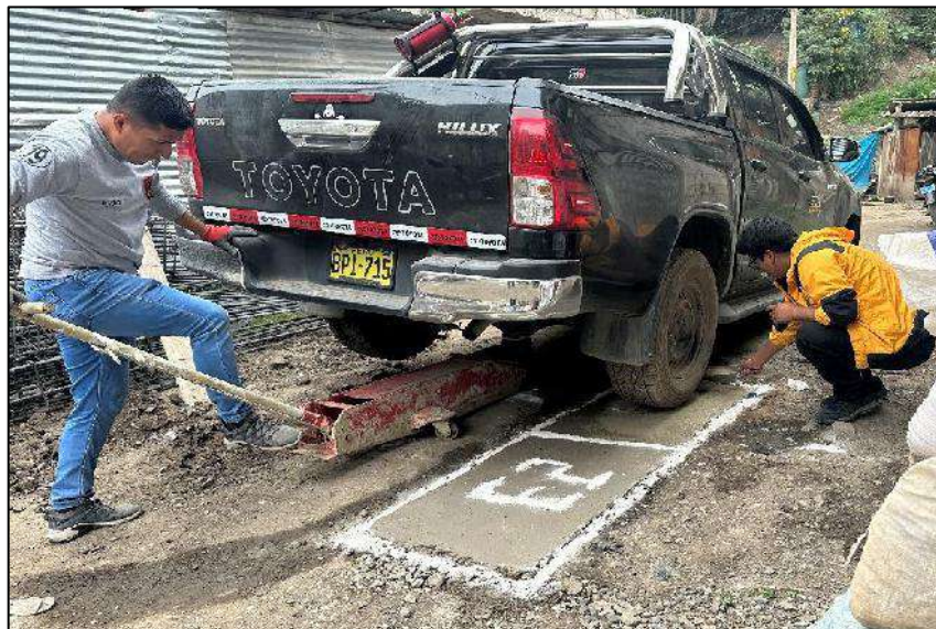
Figura 88 — Control del desgaste del pavimento con agregado de cantera
