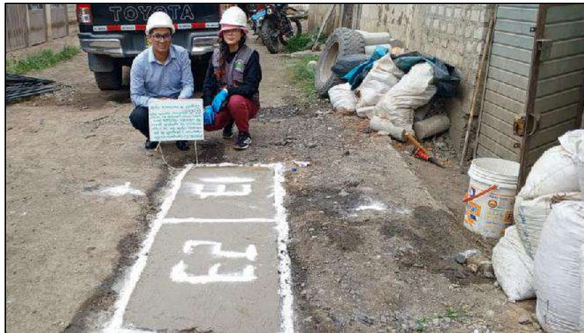
Figura 87 — Preparación del pavimento para la evaluación del desgaste
