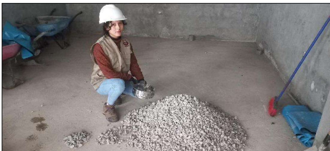
Figura 43 — Preparación del agregado del concreto reciclado
