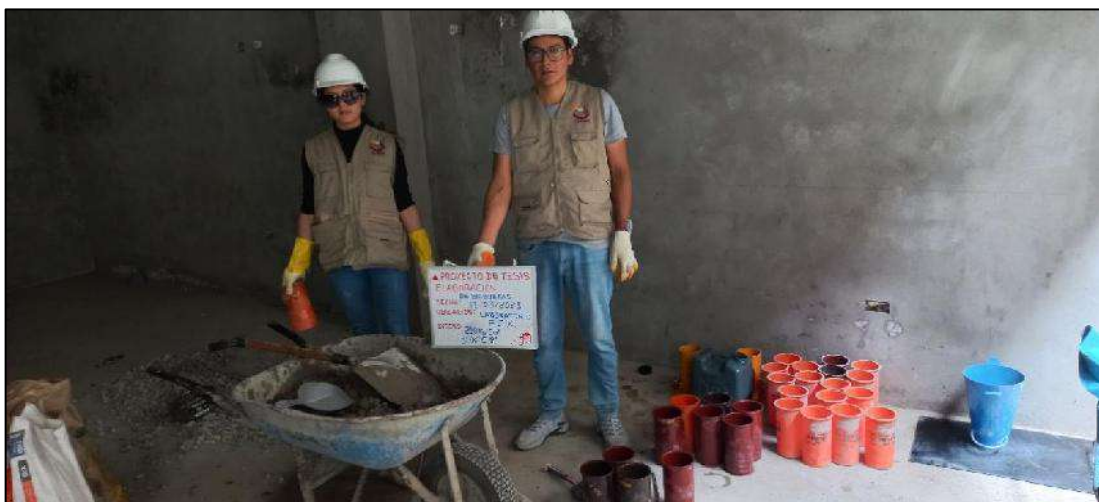
Figura 61 — Preparación manual del concreto f'c=210 \text{ kg/cm}^2 para el G 3
