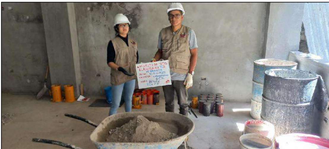
Figura 68 — Preparación manual del concreto f'c=210 \text{ kg/cm}^2 para el G 6
