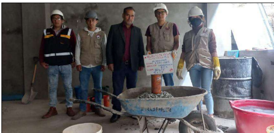
Figura 64 — Preparación manual del concreto f'c=210 kg/cm 2 para el G 4
