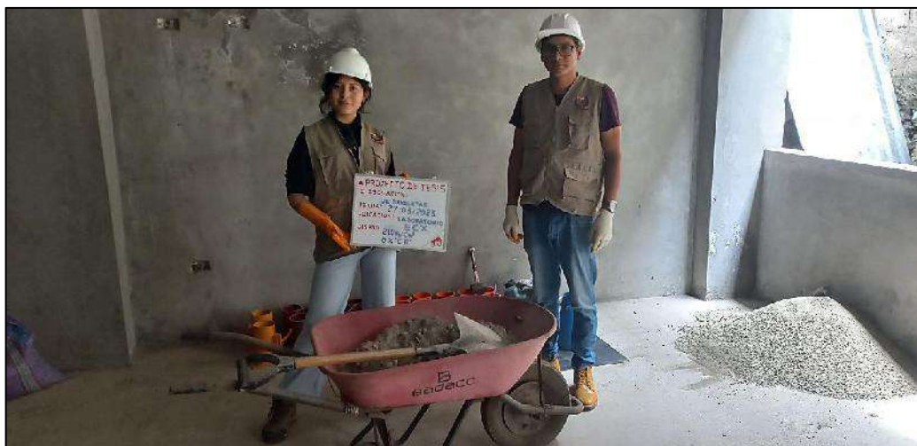
Figura 57 — Preparación manual del concreto f'c=210 kg/cm 2 para el G 1
