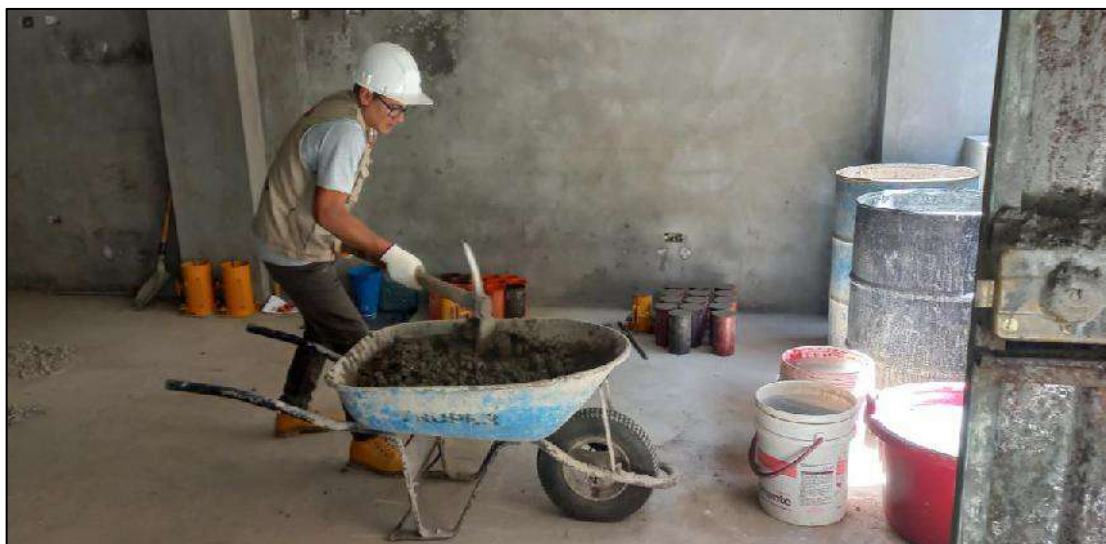
Figura 69 — Mezcla manual del concreto f'c=210 \text{ kg/cm}^2 para el G 6
