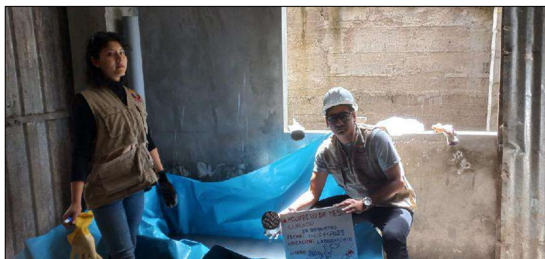
Figura 74 — Curado de testigos de concreto (G 3 )
