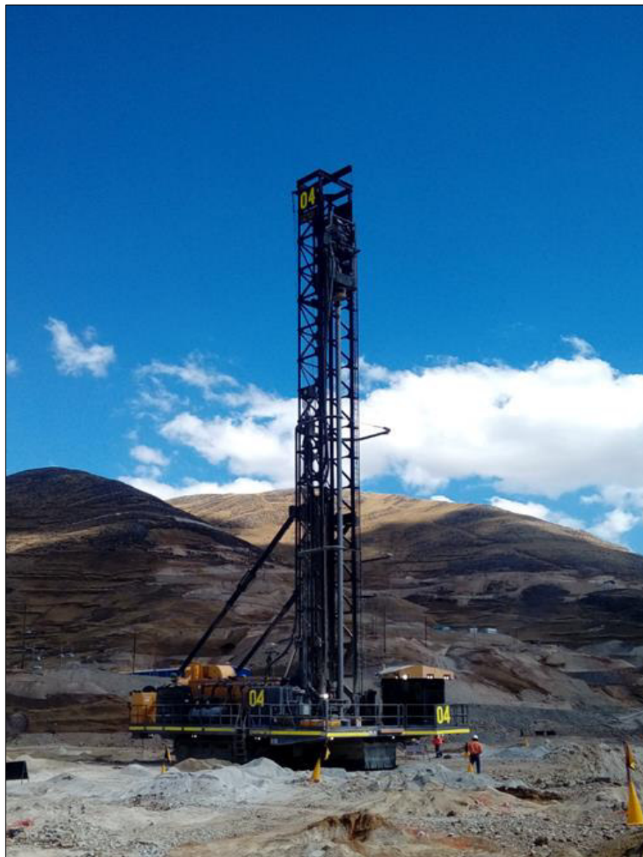
Fotografía 2-3: Perforadora P&H 250 XP.
