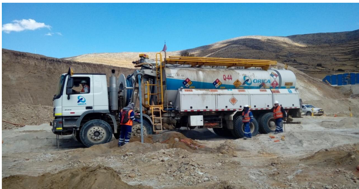
Fotografía A-30: Carguío de taladros con M.M.U. (Bombeable). Fuente: Elaboración propia.
