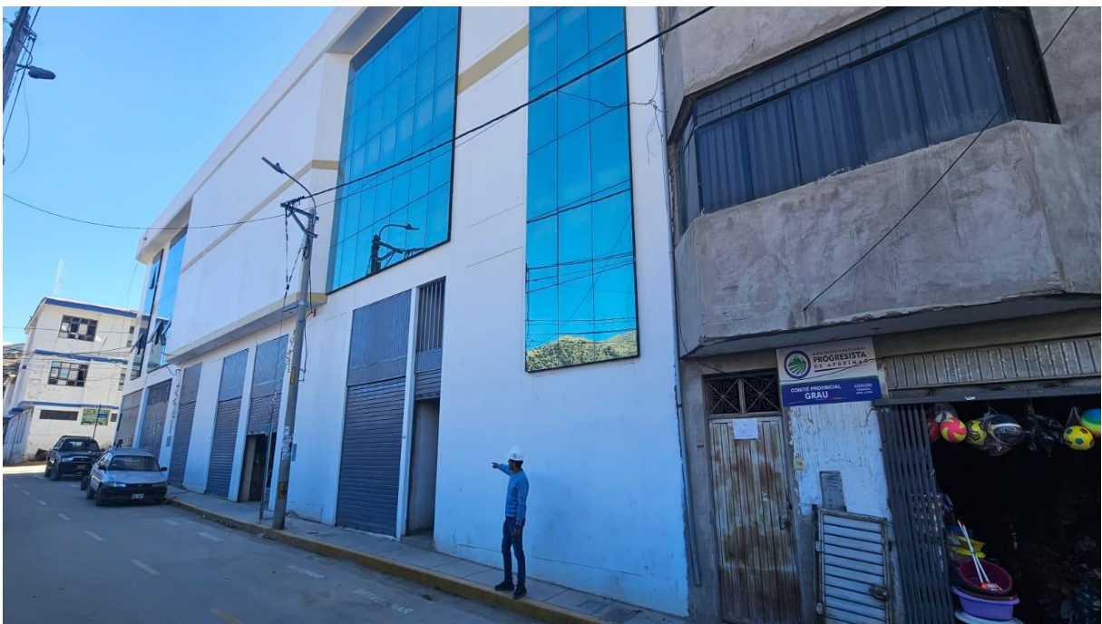
Figura 55 — Vista panorámica correspondiente al bloque B del mercado Municipal de Chuquibambilla
