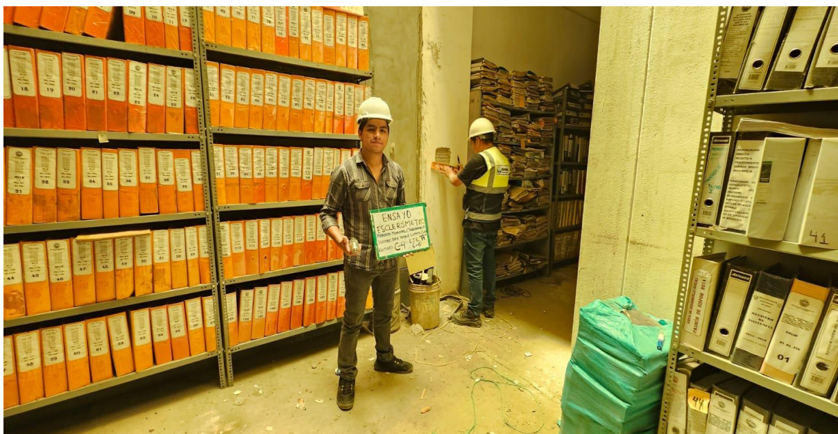
Figura 56 — Ejecución de la Prueba de Esclerometría para la Evaluación de la Resistencia del Concreto en Columnas
