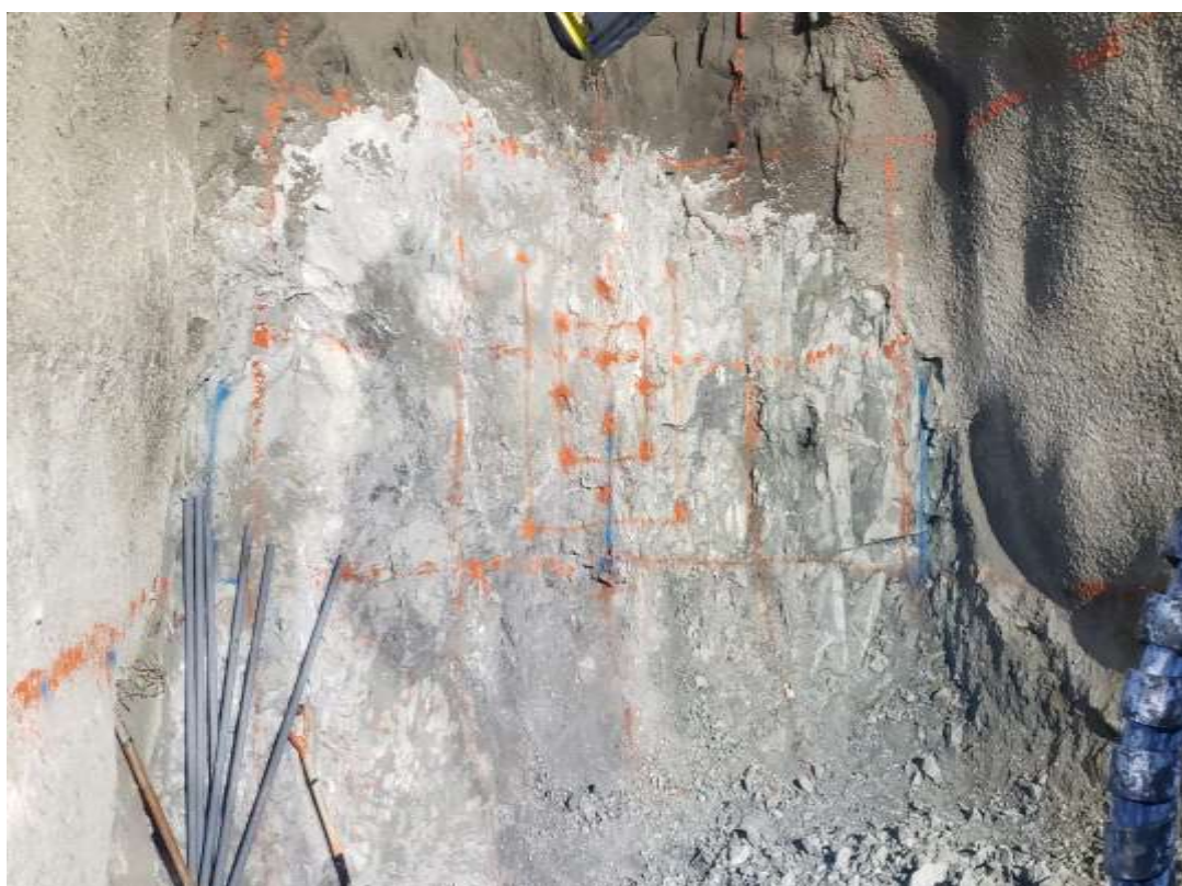
Figura 35 — Marcado final de la nueva malla estandarizada
