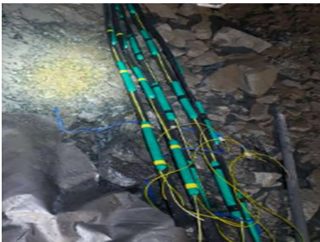
Figura 37 — Instalación de cañas
