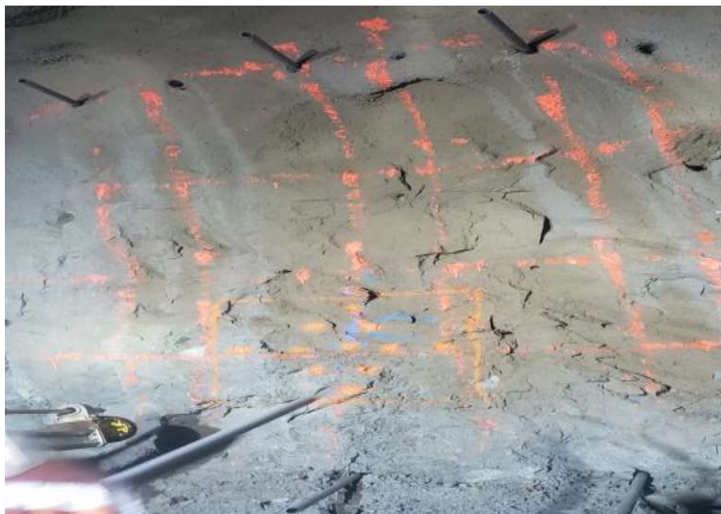
Figura 30 — Marcado de la malla de perforación estandarizada con tipo arranque circular
