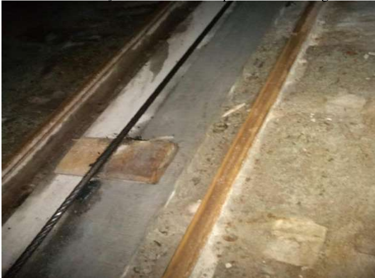
Foto N° 08: Polín y trocha de madera para evitar el desgaste del cable.
