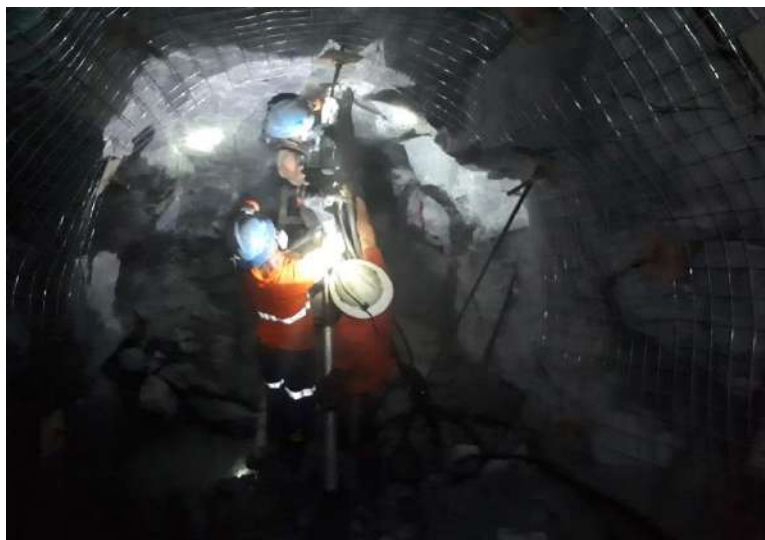
Foto N° 05: Instalación de malla electrosoldada.
