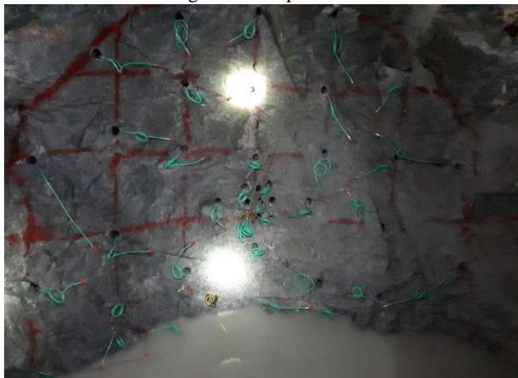
Foto N° 04: Frente cargado con explosivos.
