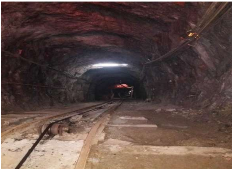
Foto N° 07: Vista del inclinado de arriba hacia abajo.
