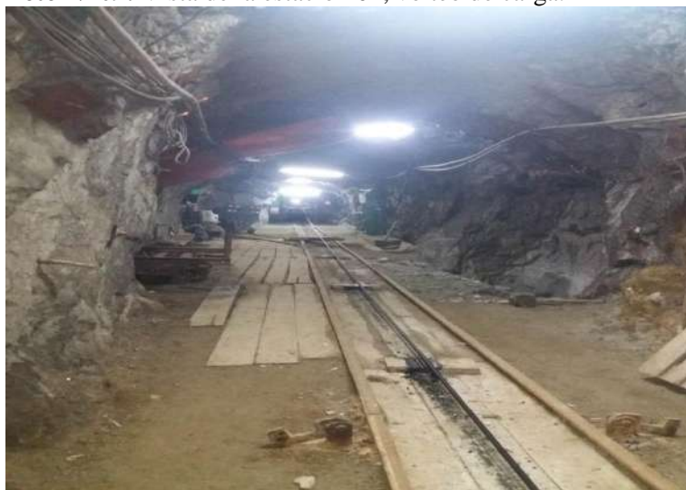
Foto N° 09: Vista de la estación 01, volteo de carga.
