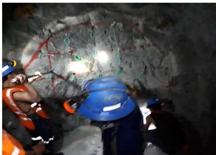
Foto N° 02: Carguío del frente con explosivos del inclinado 8707.
