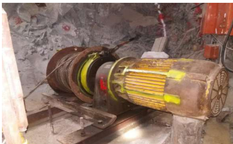
Foto N° 06: Winche de izaje de 30 hp.
