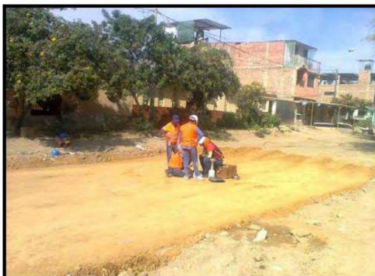
Figura 13 — Ejemplo de una capa de Sub base
