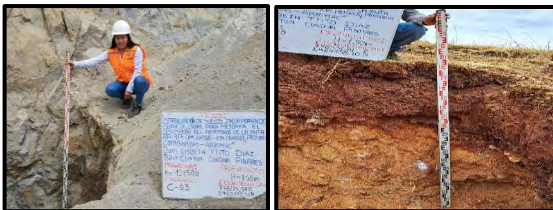
Figura 34 — Extracción de la muestra calicata 03 (margen derecho h = 1.5 m) y calicata 04 (margen derecho h = 1.5 m)
