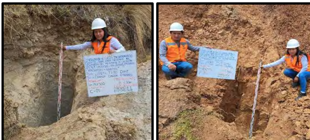
Figura 35 — Extracción de la muestra calicata 05 (margen derecho h = 1.5 m) y calicata 06 (margen izquierdo h = 1.5 m)
