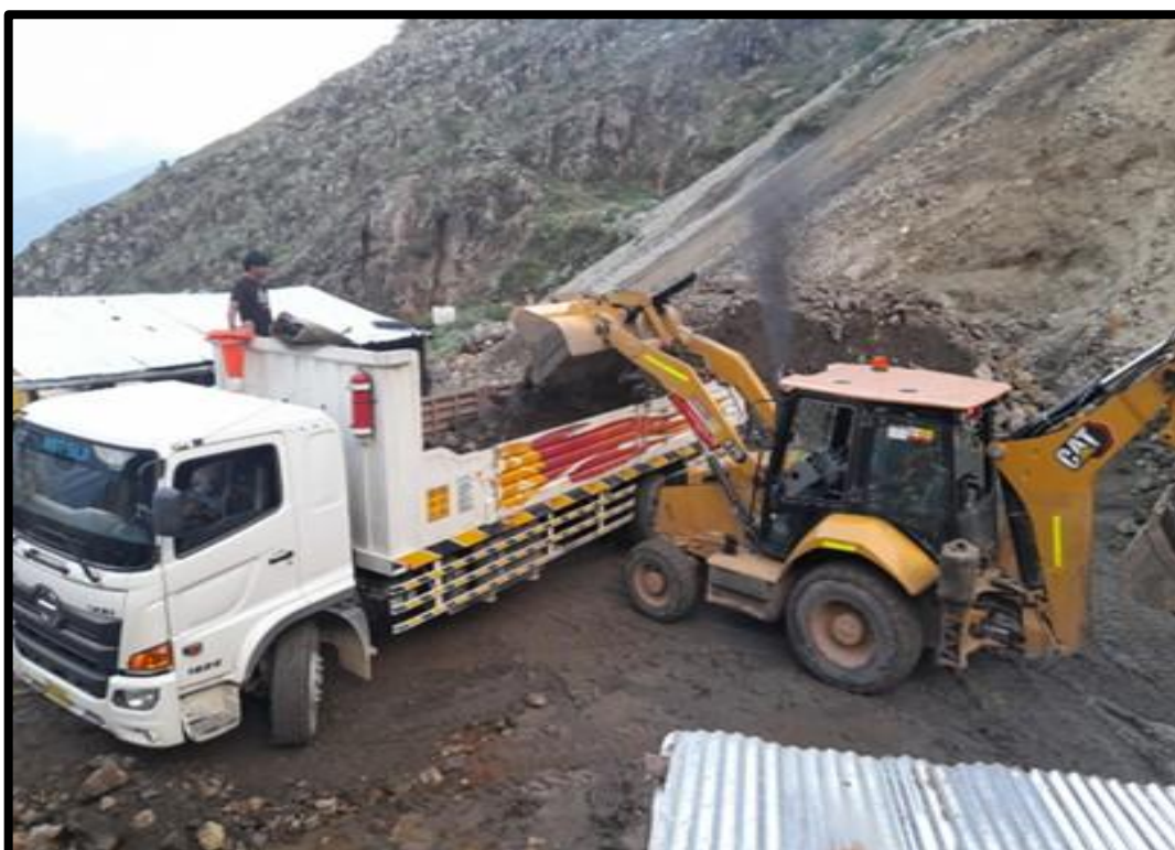
Figura 23 — Carguío de material con equipo pesado
