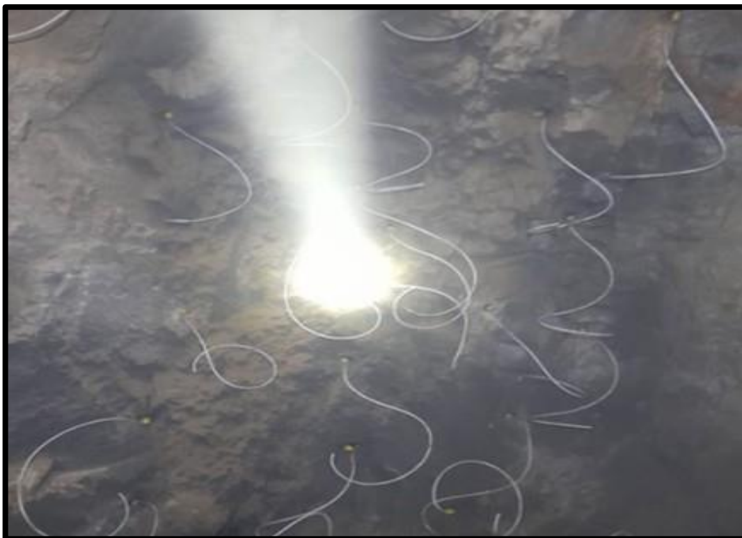
Figura 18 — Instalación de carga explosiva
