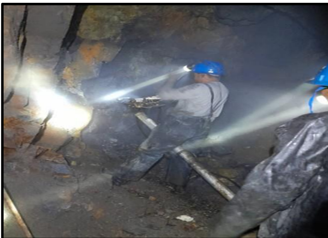
Figura 22 — Operación de perforación en el frente de avance
