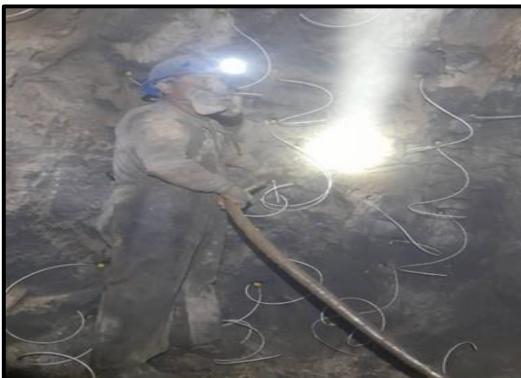
Figura 19 — Preparación de la voladura
