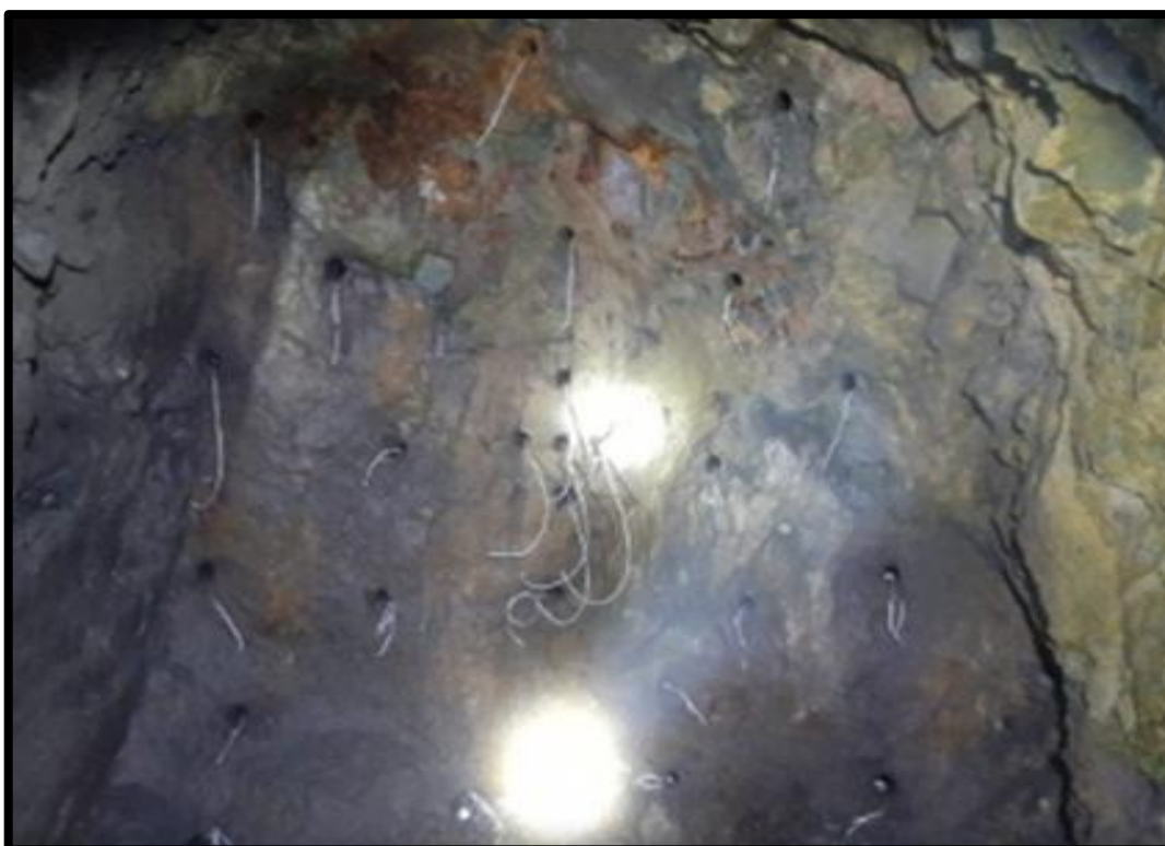
Figura 20 — Frente de perforación con taladros cargados
