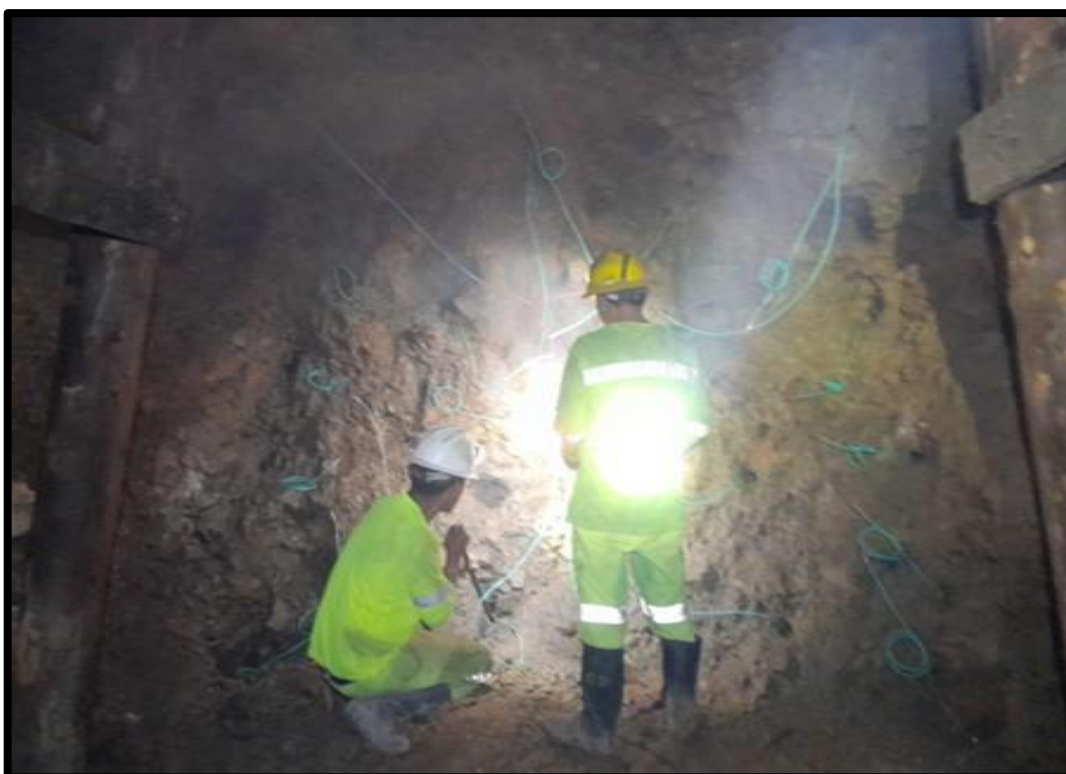
Figura 26 — Preparación de carga explosiva en el frente de trabajo
