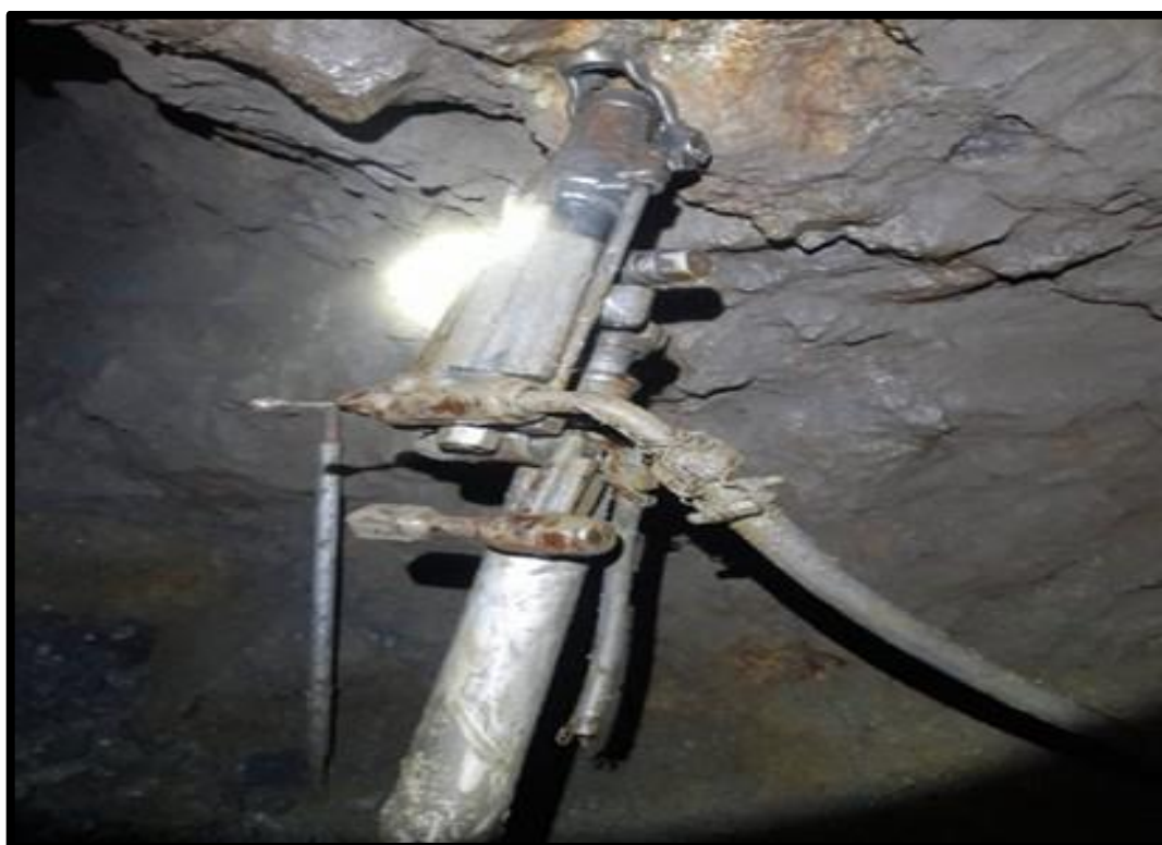
Figura 17 — Equipo de perforación
