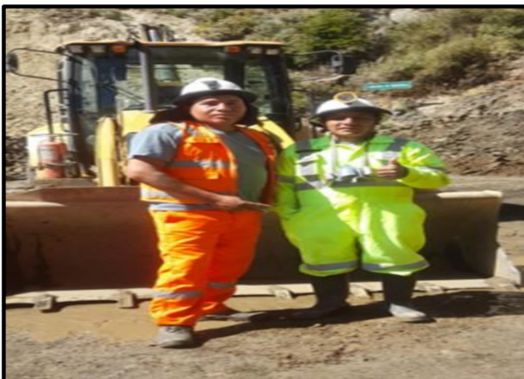
Figura 27 — Personal en zona de operaciones con equipo pesado
