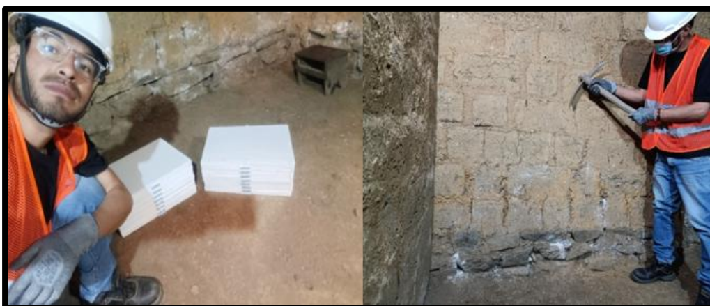
Figura 30 — Inicio del proceso de colocación de baldosas en muros interiores
