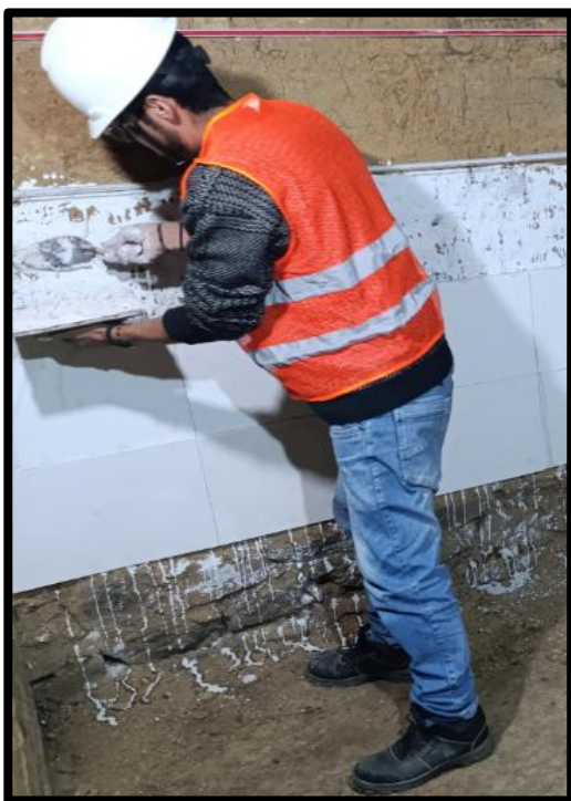
Figura 32 — Resane de huecos en muros de adobe y colocación de baldosas
