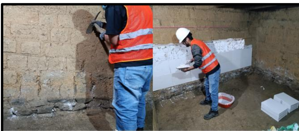
Figura 31 — Perfilado, nivelación de muros interiores y colocación de baldosas
