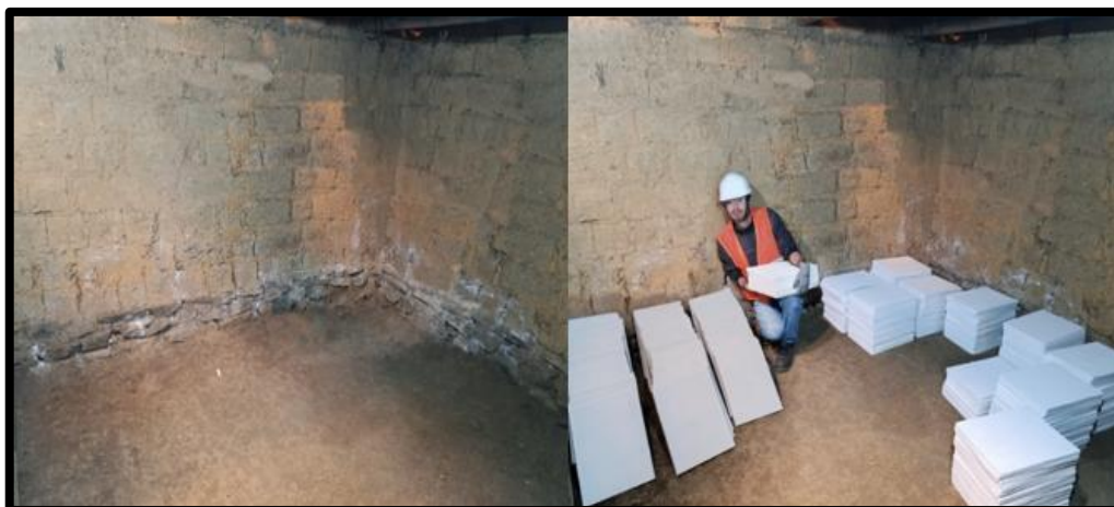
Figura 29 — Interior de la vivienda de adobe más las baldosas
