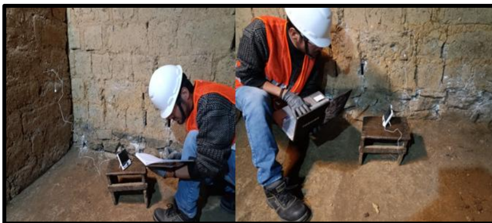
Figura 27 — Recolección de datos en la vivienda sin baldosa
