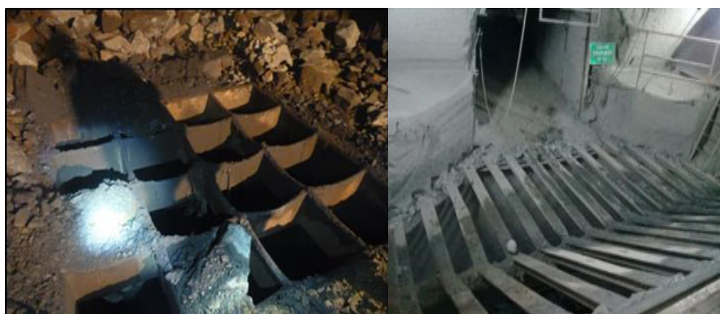
Fuente: Toma de Fotografías In-situ
