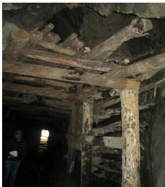
Ilustración 11 Cuadros de madera Nivel 01
