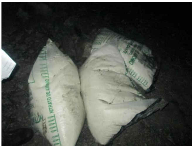
Foto 03: preparación de anfo en interior mina
