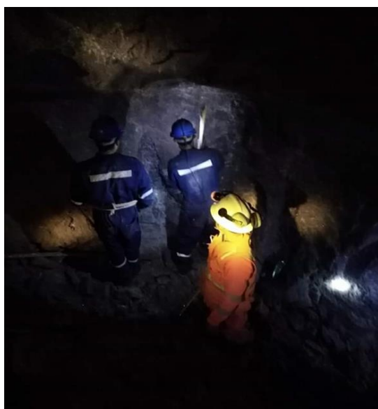
Ilustración 10 Trabajos de Perforación
