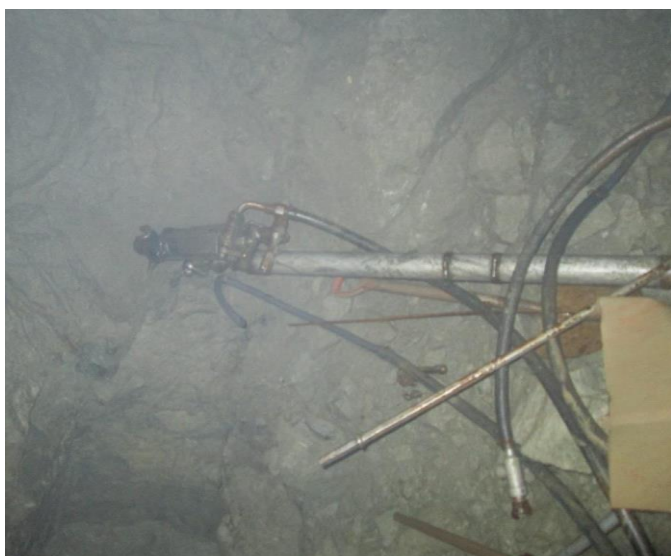
Foto 04: vista de una perforadora
