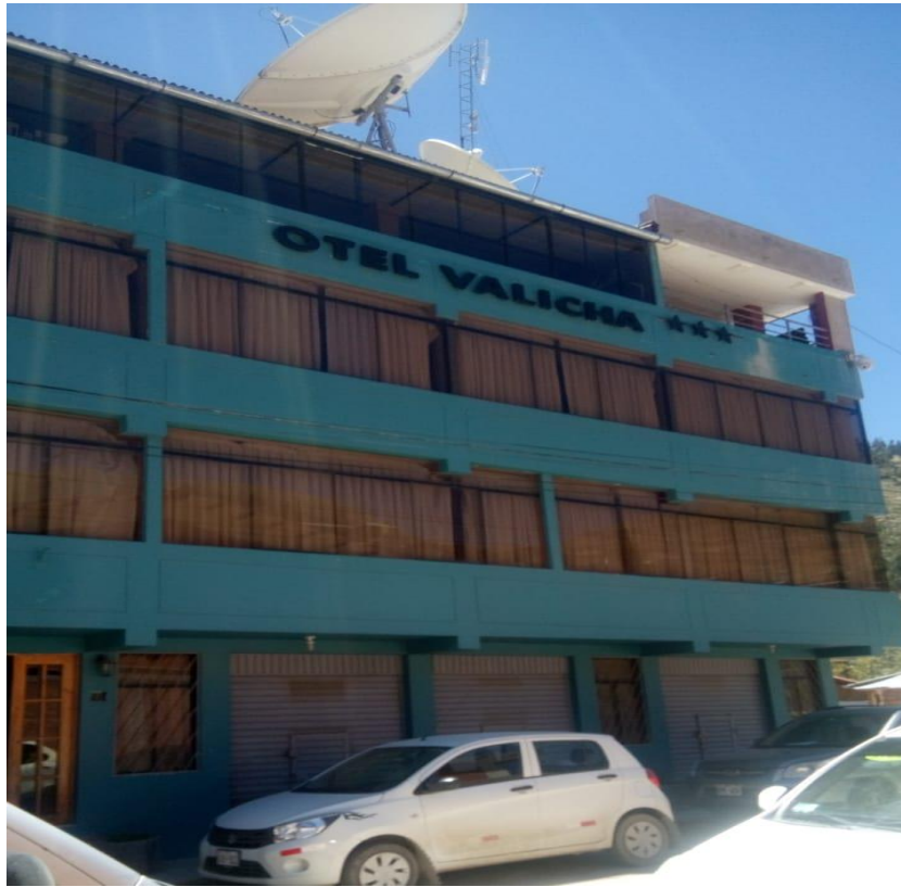
Imagen de la infraestructura del hotel Valicha
