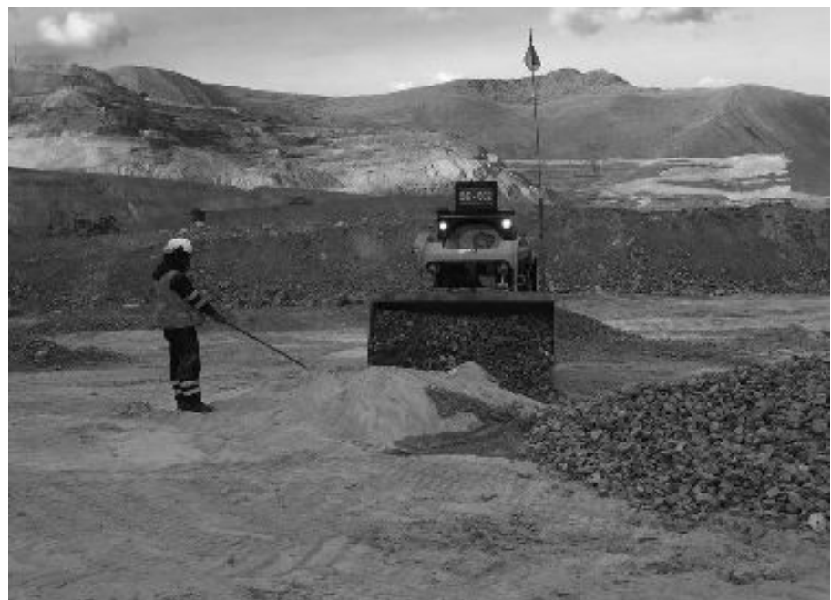
Figura 36. Tapado de taladros con minicargador Fuente: Elaboracion propia
