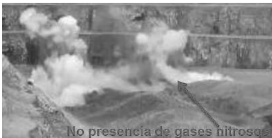
Figura 132. 3ra voladura Vistis 250: Proyecto 3810-074 Analisis de humos
